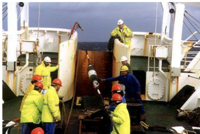
Εικόνα 39. Τυπική φωτογραφία ενός σύγχρονου ταχυσυνδέσμου UQJ
