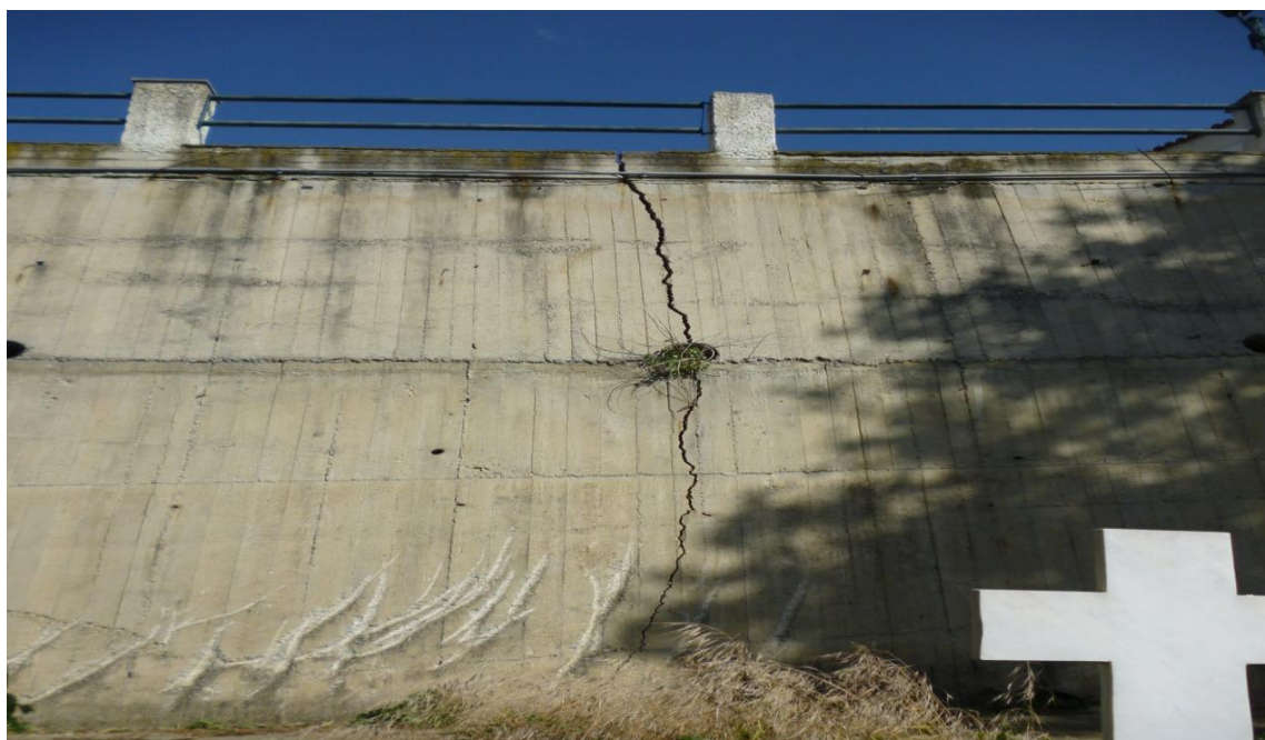
Εικόνα 4.9 Εμφανείς ρωγμές σε κοιμητήριο, στην περιοχή Σταγιάτες
