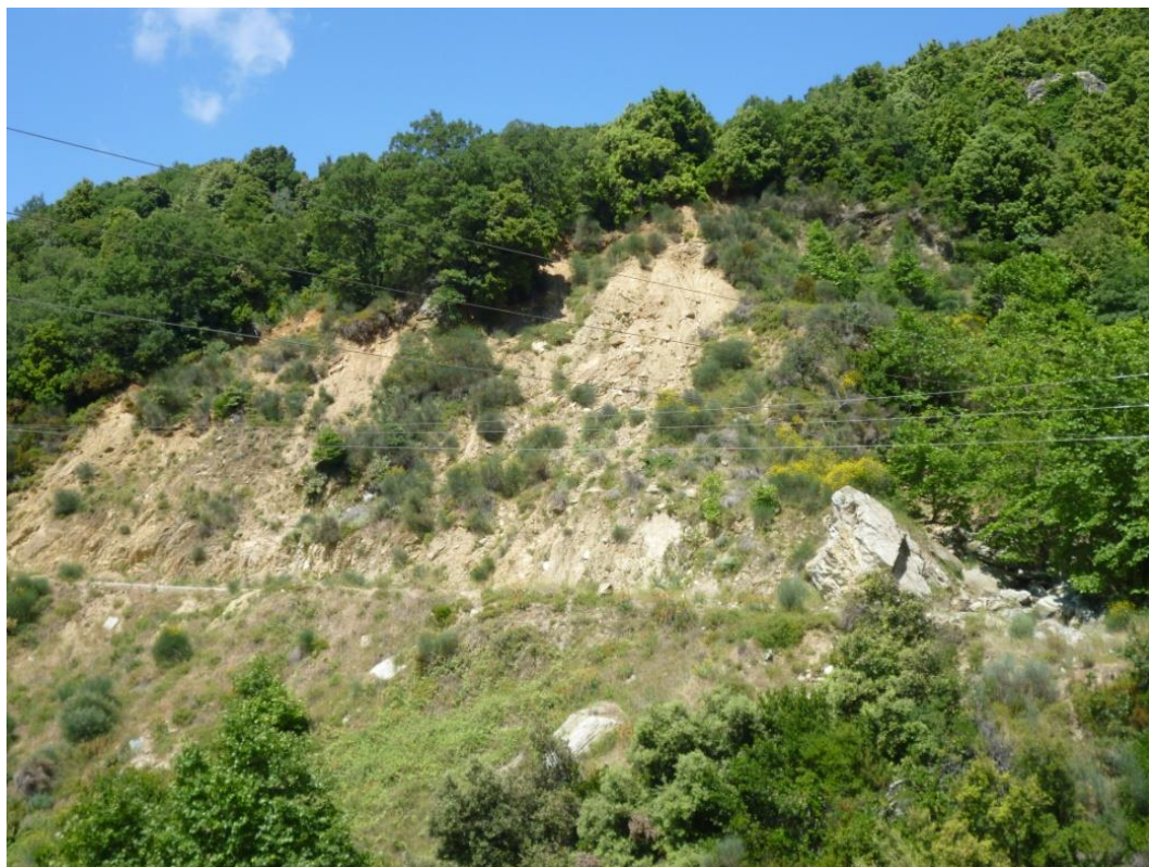
Εικόνα 2.5 Κατολίσθηση η οποία παρατηρήθηκε στο οδικό δίκτυο προς τον οικισμό Βυζίτσας
