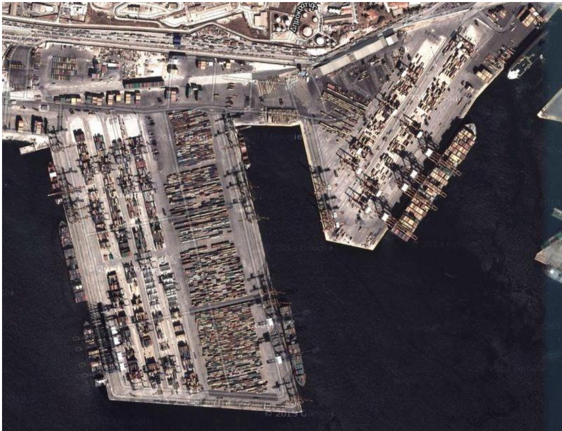
Εικόνα 41: Ο χώρος στοιβασίας των εμπορευματοκιβωτίων σε τραπεζοειδές κρηπίδωμα, και η σιδηροδρομική εγκατάσταση πάνω από το κρηπίδωμα.
