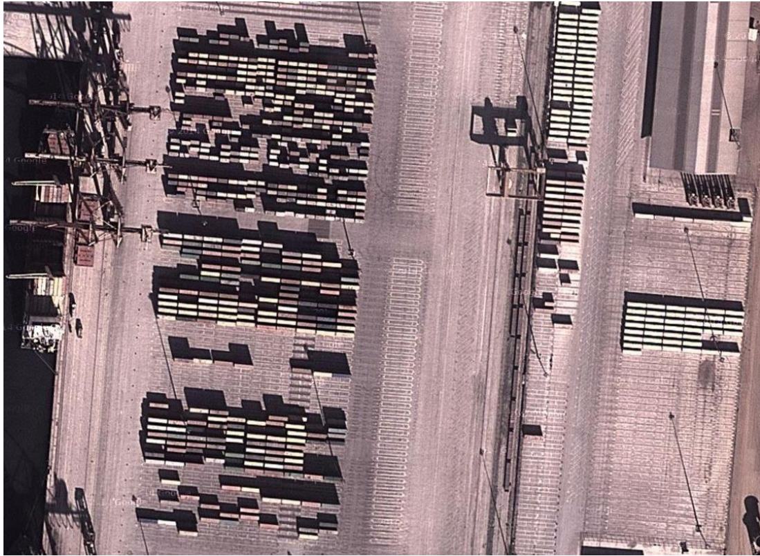
Εικόνα 44: Λεπτομέρεια της σιδηροδρομικής εγκατάστασης
