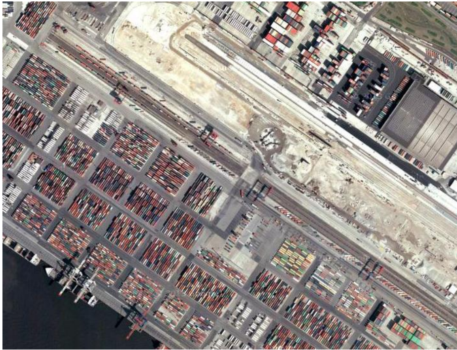
Εικόνα 17: Διάταξη «πλησίον του χώρου στοιβασίας» στον λιμένα του Αμβούργου
