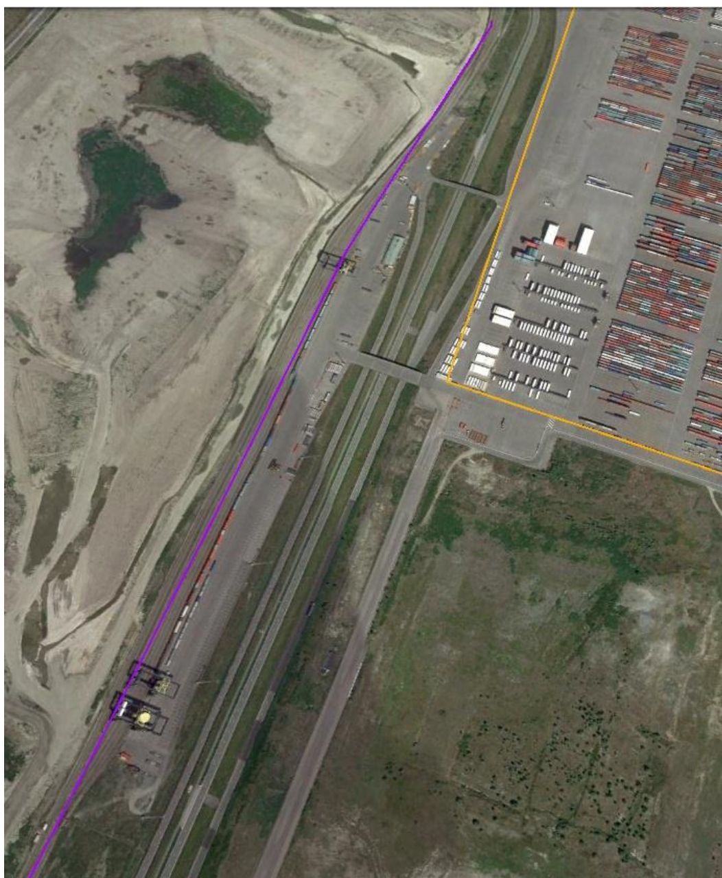
Εικόνα 27: Νοτιοδυτική σιδηροδρομική εγκατάσταση και οι γερανογέφυρες
