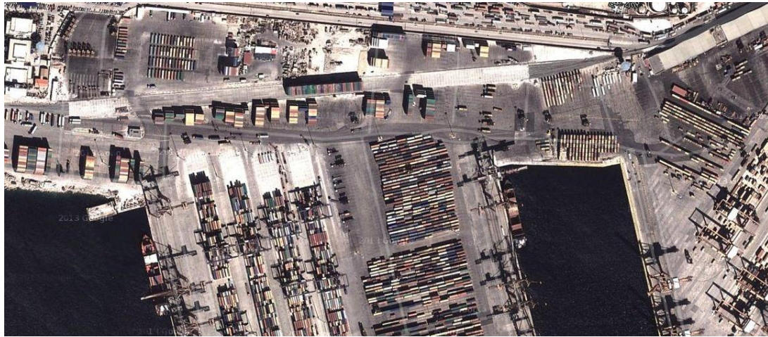
Εικόνα 42: Λεπτομέρεια της σιδηροδρομικής εγκατάστασης
