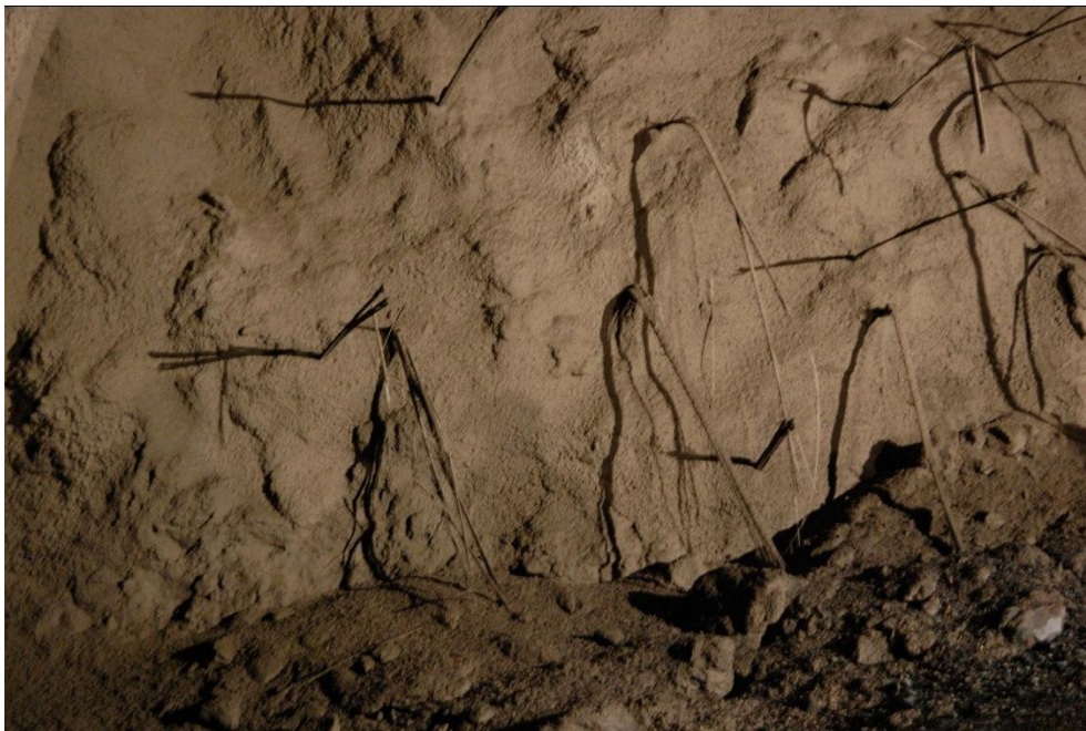
Εικόνα 1.2.3: Αγκύρια μετώπου μετά από εκσκαφή βήματος
