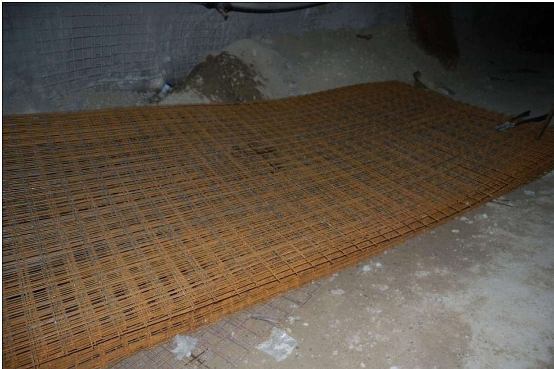
Εικόνα 1.1.2: Πλέγματα πριν την τοποθέτηση στη σήραγγα Δερβένι της ΠΑΘΕ.
