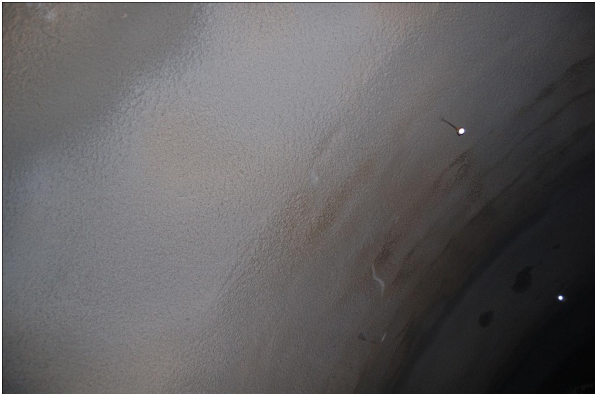
Εικόνα 1.1.1: Επιφάνεια εκτοξευομένου σκυροδέματος στη σήραγγα Δερβένι της ΠΑΘΕ.
