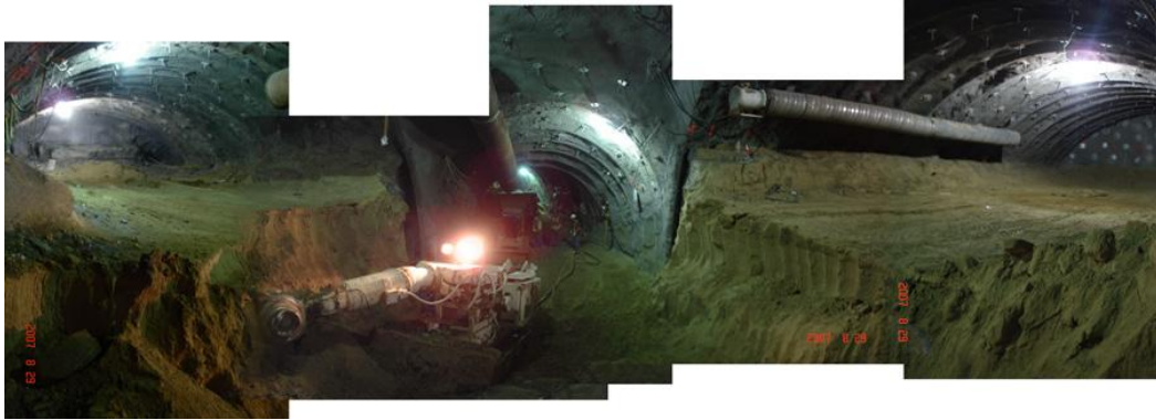
Εικόνα 1.2.6: Διάνοιξη με τη λογική του top heading
