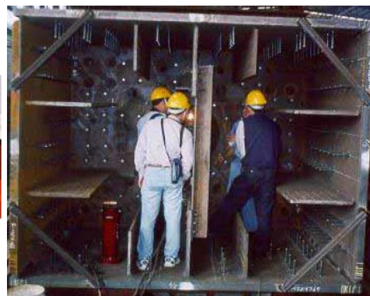
Εικόνα 3.11: Σύμμικτο υποστύλωμα Ουρανοξύστη
