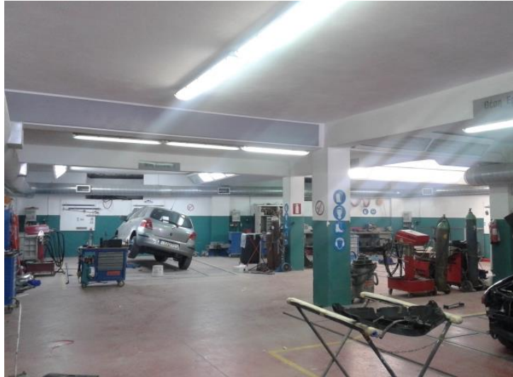
Εικόνα 4.1: Κάτω επίπεδο-Χώροι Εργασίας Φανοποιείου
