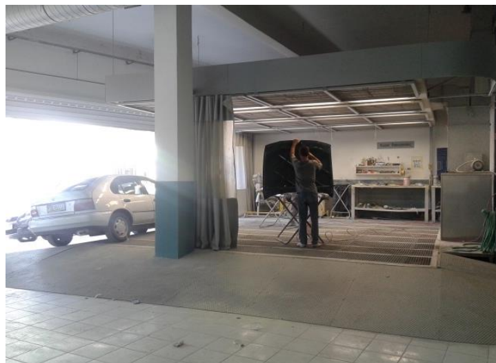
Εικόνα 4.2: Άνω επίπεδο-Χώρος προεργασίας της βαφής
