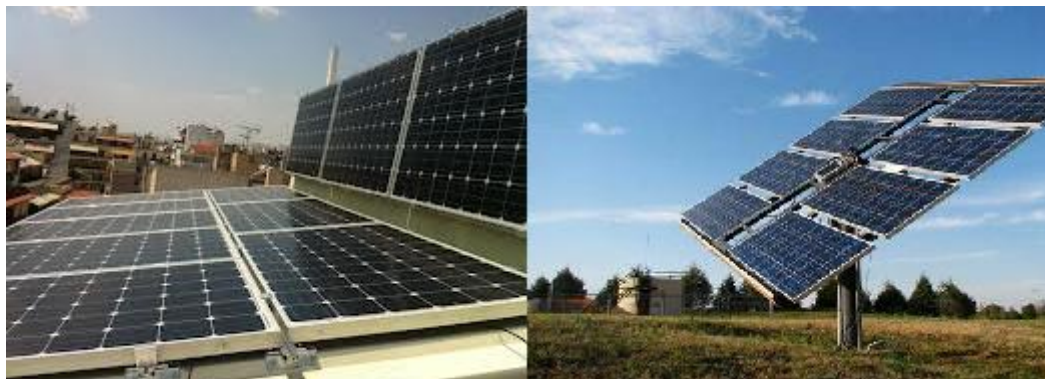
Εικόνα 2.4: Αριστερά: Συστοιχίες Φ/Β πλαισίων σε οριζόντια και κάθετη διάταξη, Δεξιά: Αυτόματο περιστρεφόμενο Φ/Β πλαίσιο
