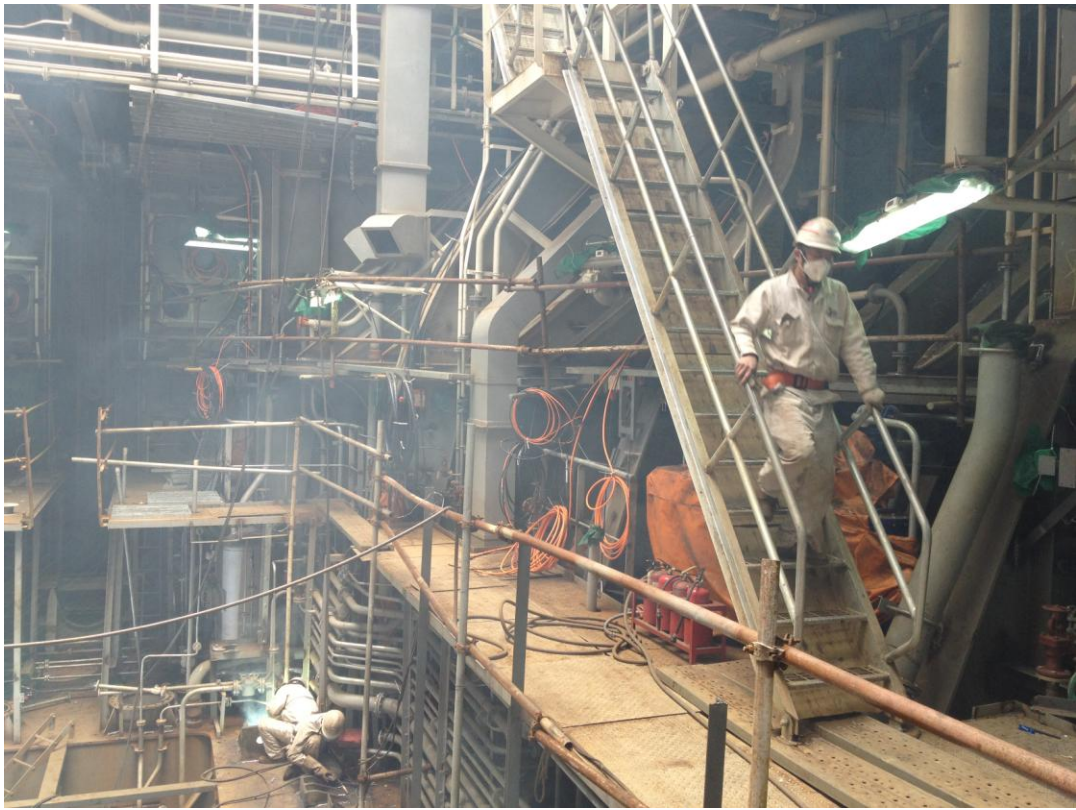
Κατασκευή μηχανοστασίου (Κίνα)
