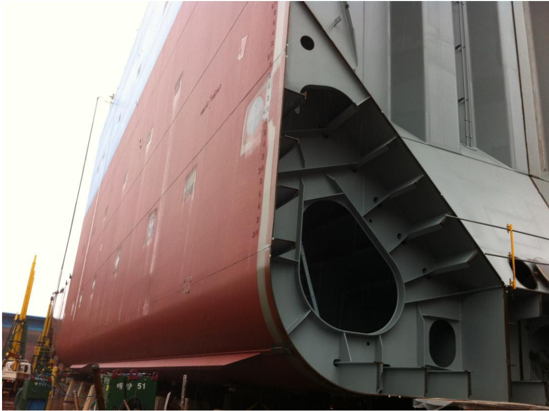
Κατασκευή τομέων Κορέα
