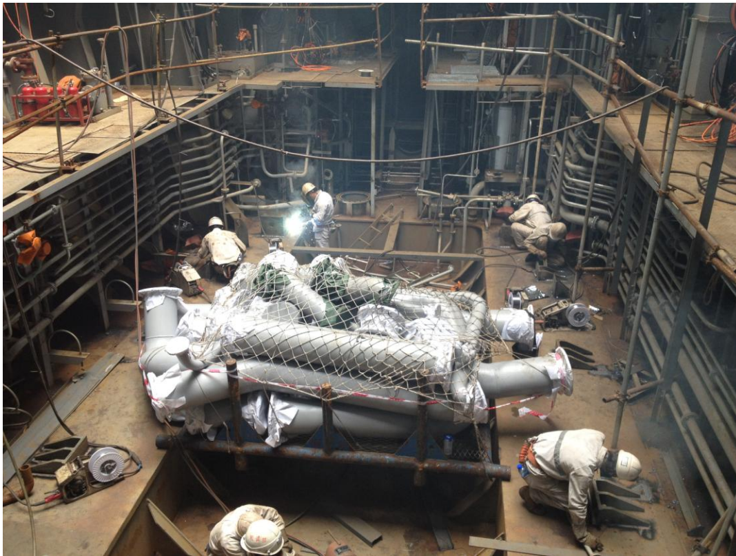
Κατασκευή μηχανοστασίου (Κίνα)
