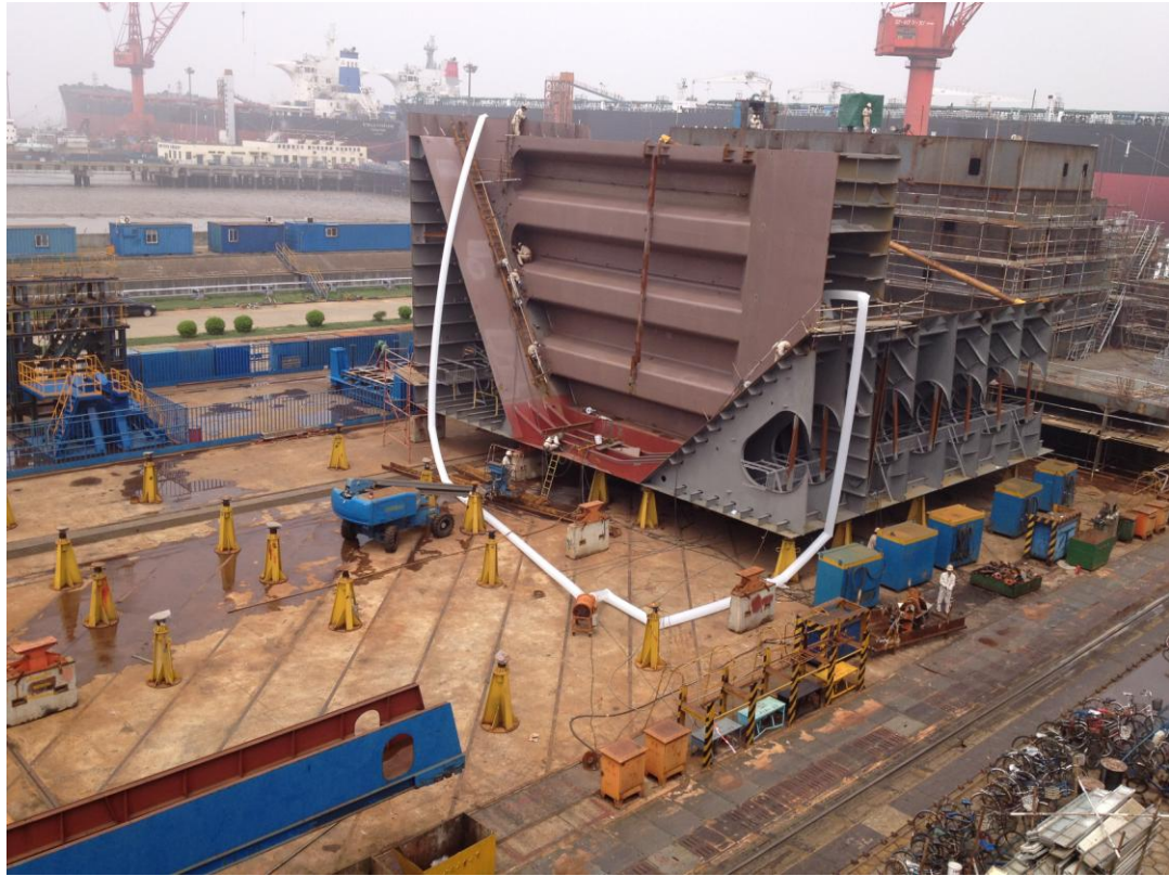
Κατασκευή μεγάλων τομέων (Κίνα)
