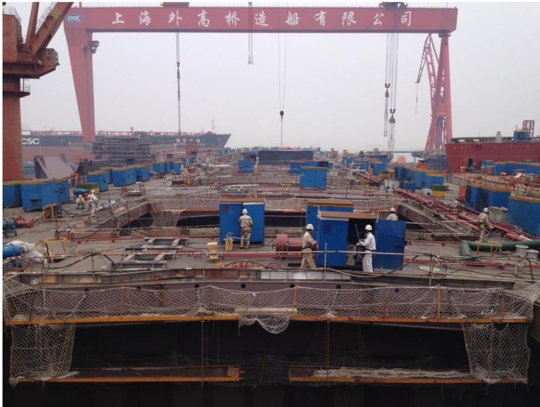
Εργασίες στο κατάστρωμα κατά την συγκόλληση των τομεων (Κίνα)
