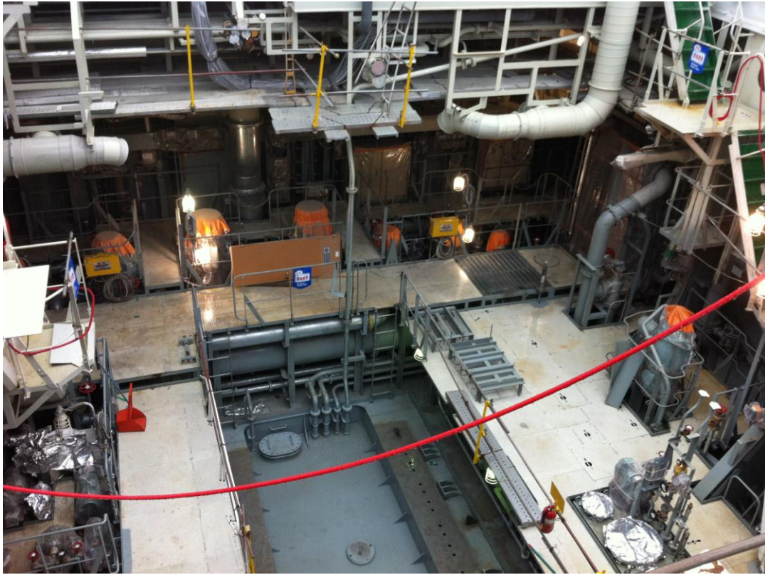
Κατασκευή μηχανοστασίου Κορέα
