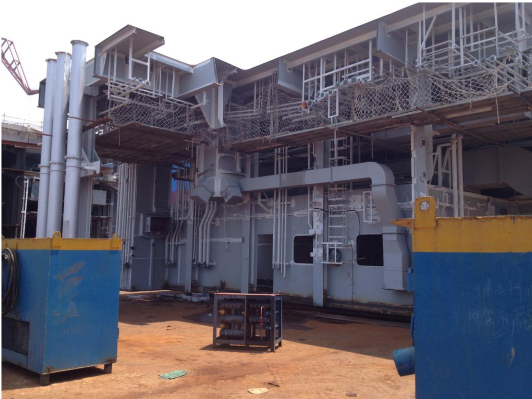
Κατασκευή ενδιατησης (Κίνα)
