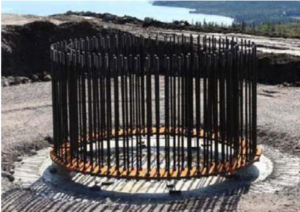
Εικόνα 2.10: Μορφή θεμελίωσης με αγκύρια υψηλής αντοχής
