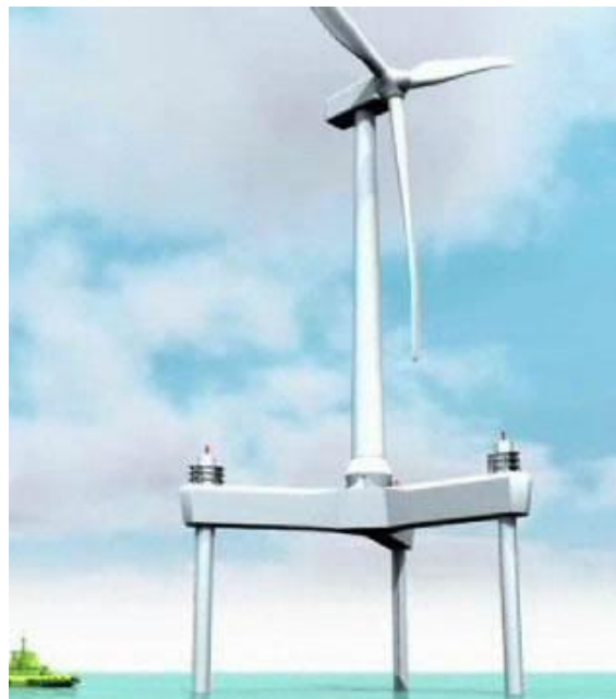
Εικόνα 2.15: Κατασκευή στήριξης τύπου τριπλού πυλώνα
