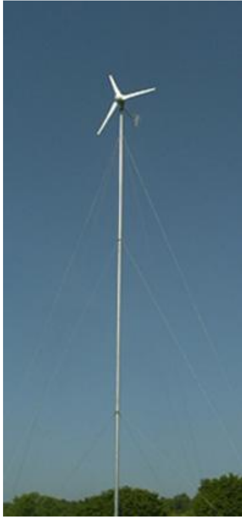
Εικόνα 2.9: Σωληνωτός πύργος που στηρίζεται σε επίτονα
