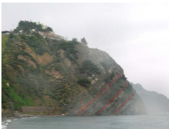
Εικ. 2.4: Το πρανές και η κλίση των εδαφικών στρώσεων
