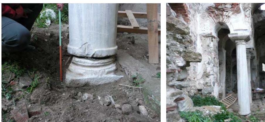
Εικ. 3.7, 3.8 : Θεμελίωση βάσης και απόκλιση δυτικού κίονα βόρειας κιονοστοιχίας
