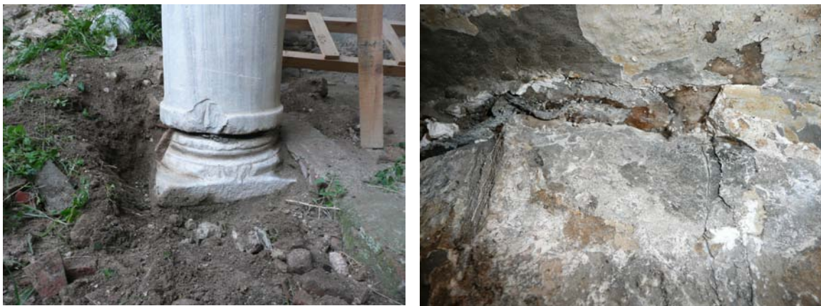
Εικ. 3.14, 3.15 : Τοπικές θραύσεις και διάνοιξη αρμών λόγω στροφής κίωνων
