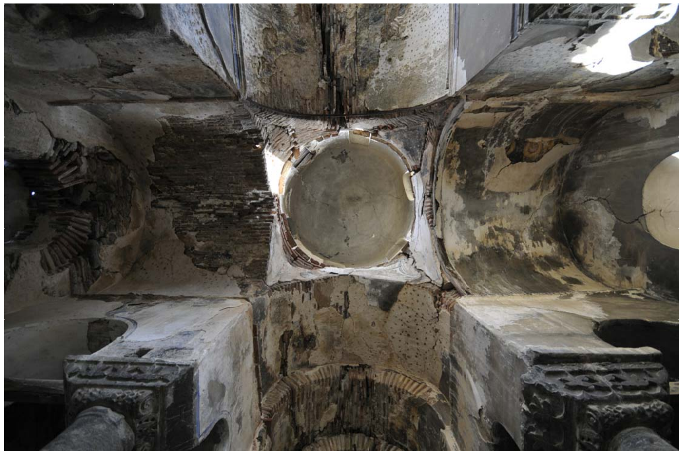
Εικ. 01.1 Άποψη της θολοδομίας. Ρηγματώσεις και απώλεια θολπών στις κλείδες των θόλων των κεραιών. Ρηγματώσεις στα σφαιρικά τρίγωνα και στον τρούλο.
