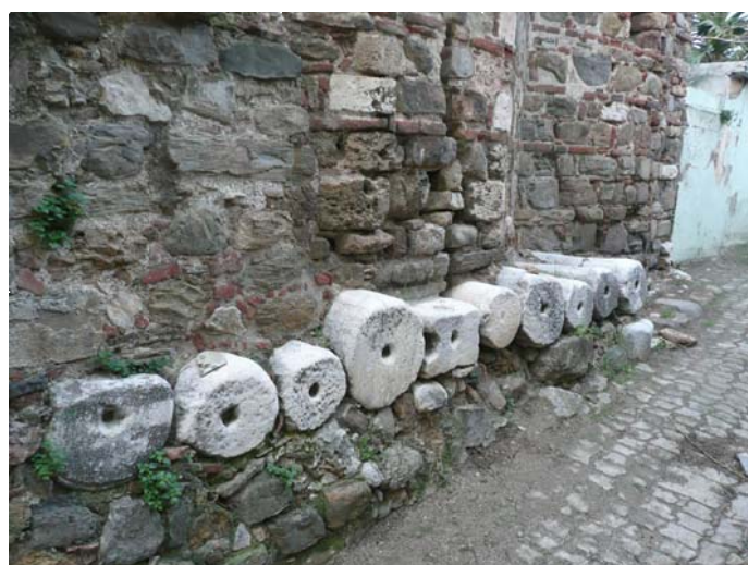
Εικ. 02.2 Έδραση κόγχης ιερού σε κυλινδρικούς σφοδύλους κίωνων. Η περιοχή συνιστά το κατώτερο όριο της ρηγμάτωσης, η οποία δε συνεχίζει στο λιθόδημητο υπόβαθρο των κίωνων.
