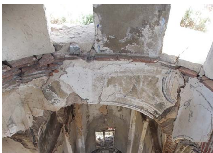
Εικ. 06.3 Ρηγμάτωσης στη βάση του τυμπάνου του τρούλου, απώλεια οπτοπλίνθων.
