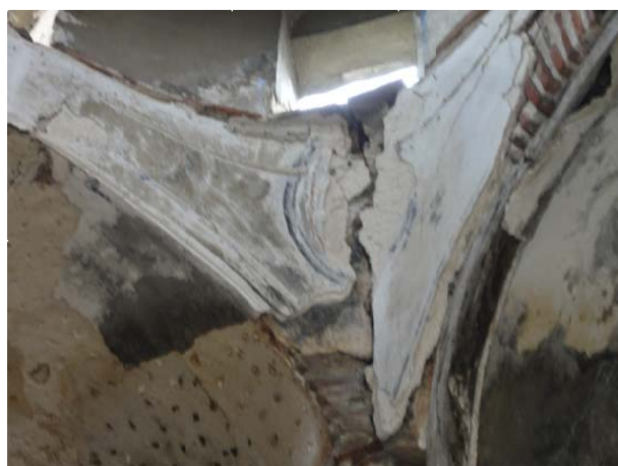
Εικ. 06.2 Ρηγμάτωση του σφαιρικού τριγώνου μεταξύ τρούλου και θόλου.
