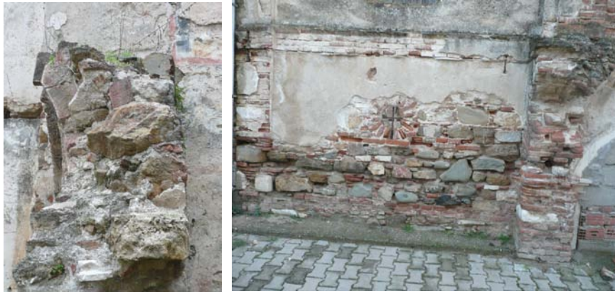
Εικ. 3.2 : Υλικά δόμησης (κατακόρυφοι τοίχοι)
