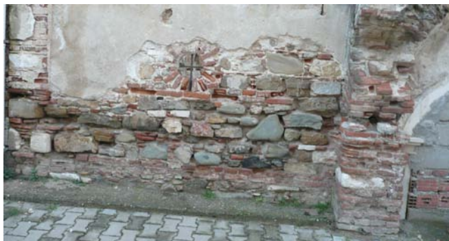
Εικ. 3.6 : Απόπλυση κονιαμάτων και θραύσεις οπτοπλίνθων στο επίπεδο θεμελίωσης
