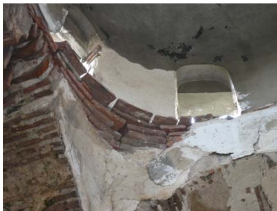
Εικ. 3.3 : Υλικά δόμησης (θολοδομία)
