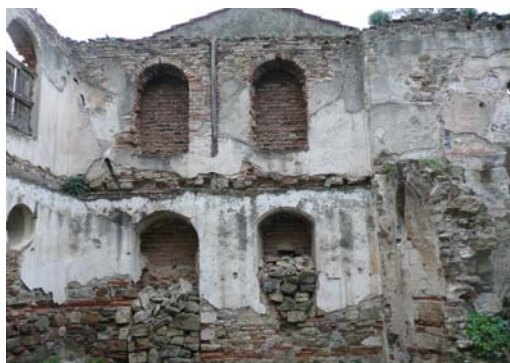
Εικ. 3.16 : Εσωτερική άποψη της προσθήκης με εμφανείς θέσεις έδρασης δοκών
