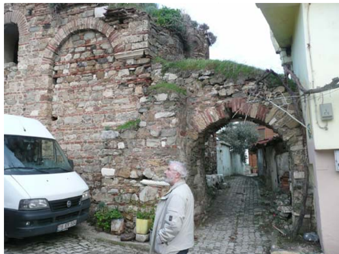
Εικ. 02.1 Άποψη ανατολικού τοίχου με αντιρήδα κατ' επέκταση του νοτίου τοίχου. Η διαπλάτυνση στη νοτιοανατολική γωνία αποτελούσε τμήμα της ανατολικότερης εκ των τριών αντιρήδων που στήριζαν το νότιο τοίχο και δε σώζονται.
