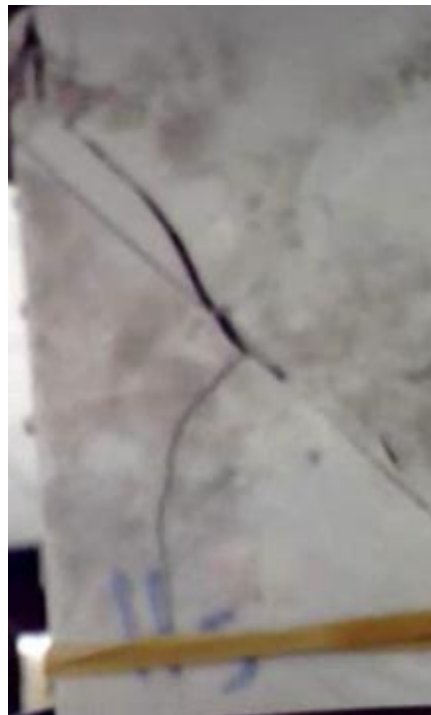
Φωτογραφία 6.71:Από τη πίσω κάμερα φαίνεται η ολίσθηση και έπειτα η δημιουργία εφελκυστικής ρωγμής.
