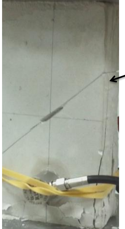
Φωτογραφία 6.40: Η εμφάνιση της εφελκυστικής ρωγμής σταματά στο επίπεδο ασυνέχειας.
