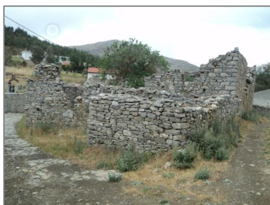
Εικ. 4.5. Τοιχοποιία κατοικίας αποτελούμενη από φυσικούς δομικούς λίθους.
