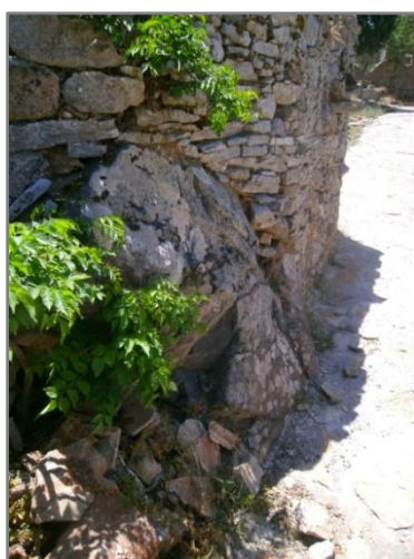
Εικ. 2.22. Θεμελίωση τοιχοποιίας σε φυσικό βράχο.
