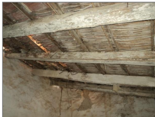
Εικ. 3.59. Δοκάρια στήριξης μονοκλινούς στέγης.
