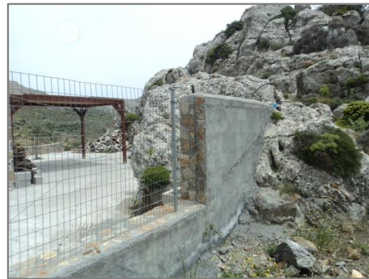
Εικ. 5.38. Υπερκάλυψη φυσικού βράχου από τοίχιο οπλισμένου σκυροδέματος...
