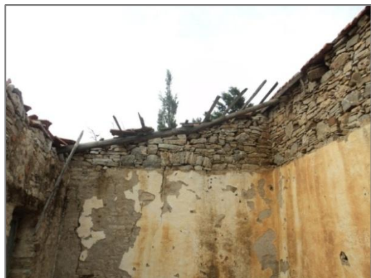
Εικ. 3.58. Διαμόρφωση τοιχοποιίας στα όρια μονοκλινούς στέγης.
