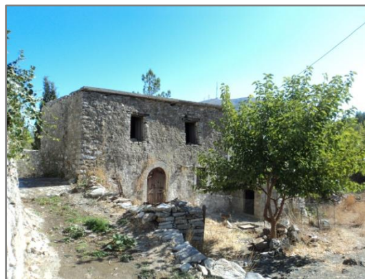
Εικ. 4.34. Φυλλοβόλο δέντρο στη νότια πρόσοψη κατοικίας.
