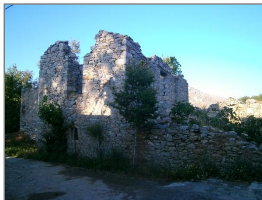
Εικ. 2.4. Διώροφη κατοικία με δίρριχτη στέγη.
