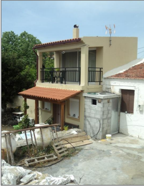
Εικ. 5.35. Αστικού τύπου νεόδμητη κατοικία.
