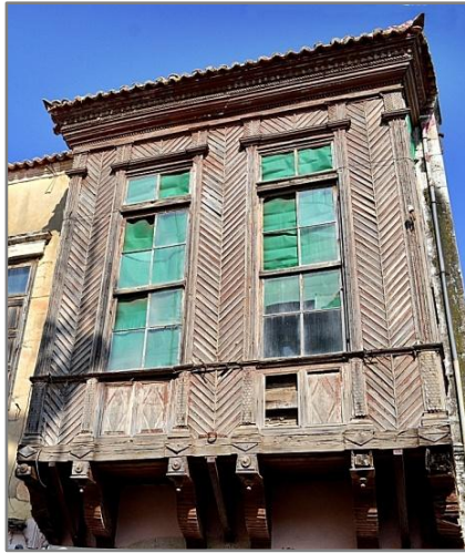
Εικ. 1.20. Σπίτι με σαχνισί στην παλιά πόλη του Ρεθύμνου.
