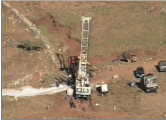
Εικ. 5.25. Διάνοιξη γεώτρησης πλησίον του οικισμού.
