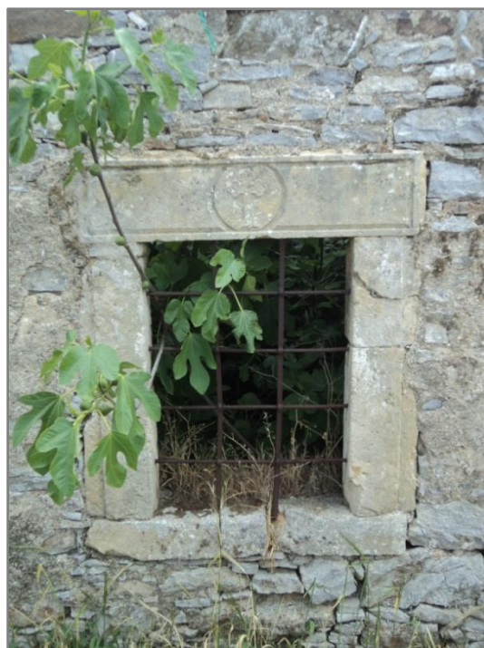
Εικ. 3.23. Παράθυρο ισογείου με λίθινο περιμετρικό ορθογώνιο πλαίσιο, ανάγλυφη επιγραφή και σιδεριά ασφαλείας.
