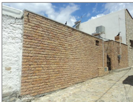
Εικ. 5.34. Εξωτερική τοιχοποιία ασύμβατη ως προς το παραδοσιακό αρχιτεκτονικό πρότυπο.
