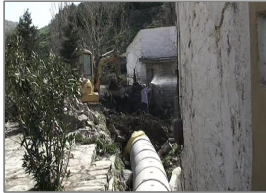
Εικ. 5.26. Τοποθέτηση αγωγού αποχέτευσης.
