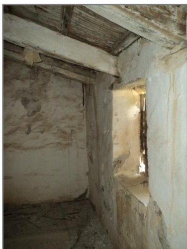
Εικ. 2.35. Εσωτερική όψη υπερυψωμένου δωματίου ύπνου (πατάρι).
