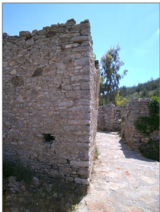
Εικ. 3.44. Γωνία εξωτερικών τοίχων κατοικίας.
