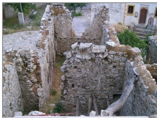
Εικ. 4.25. Μεγάλο πάχος εξωτερικής τοιχοποιίας.
