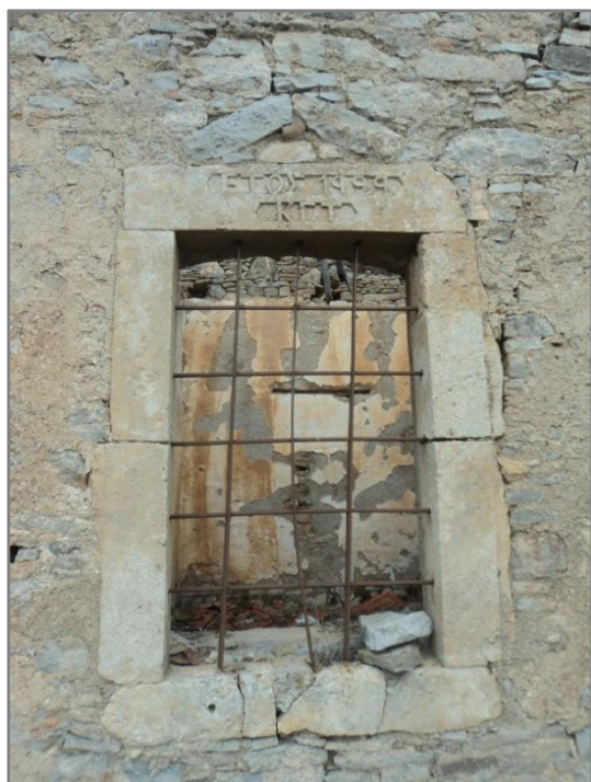
Εικ. 3.24. Παράθυρο ισόγειου με τριγωνική ανακουφιστική διάταξη στο ανώφλι.
