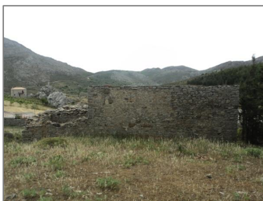
Εικ. 4.10. Τυφλοί εξωτερικοί βόρειοι τοίχοι.
