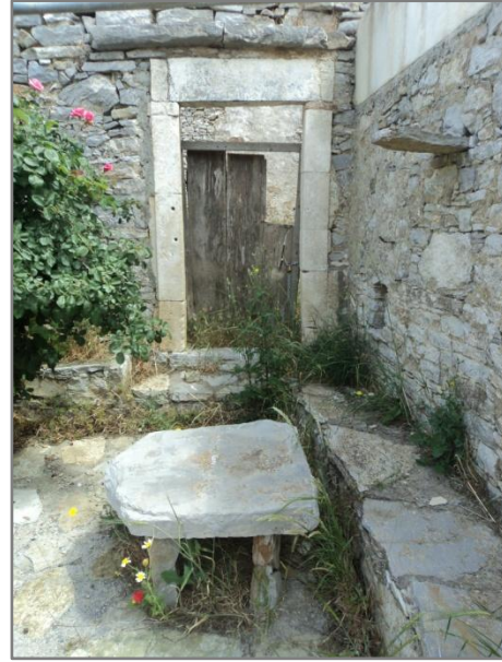
Εικ. 2.30. Πετρόκτιστη χαμηλή πεζούλα, αυτοσχέδιο λίθινο τραπέζι, βασιλικόπλακα στην παρειά του τοίχου, μορφολογικά στοιχεία εξωτερικών όψεων παραδοσιακής κατοικίας.
