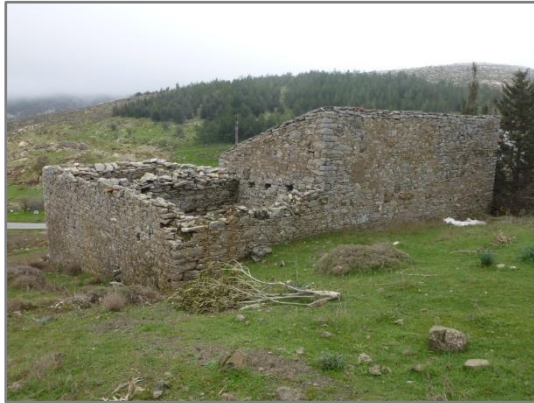
Εικ. 11. Βορειοδυτική όψη κατοικίας (τυφλοί τοίχοι).
