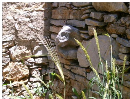
Εικ. 2.2. Λίθινη "δέστρα", ενσωματωμένη στην τοιχοποιία του σπιτιού (μικτές χρήσεις).
