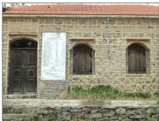
Εικ. 5.33. Πρόσοψη σχολείου οικισμού.
