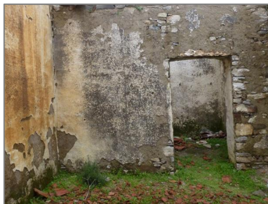
Εικ. 8. Εσωτερικός τοίχος-μεσόπορτα.
