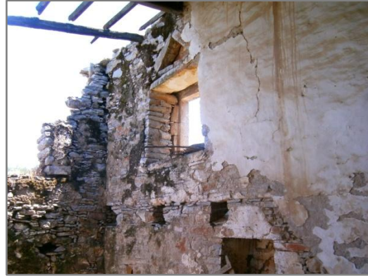
Εικ. 2.32. Εσωτερική άποψη παταριού, διακρίνονται τα ίχνη της κλίμακας και η διαμόρφωση των εσωτερικών τοίχων.
