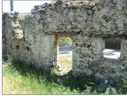
Εικ. 3.17. Εσωτερική όψη ανοιγμάτων ισόγειου σπιτιού.
