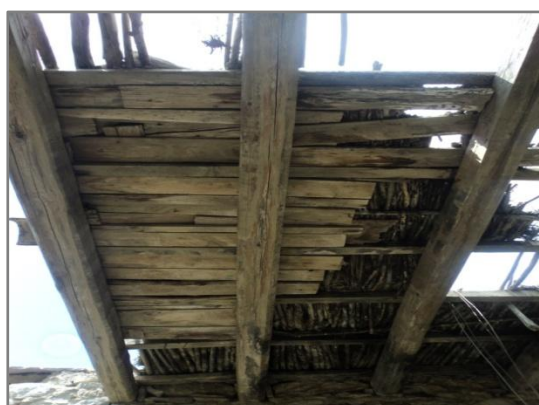
Εικ. 3.54. Εσωτερική όψη δώματος.
