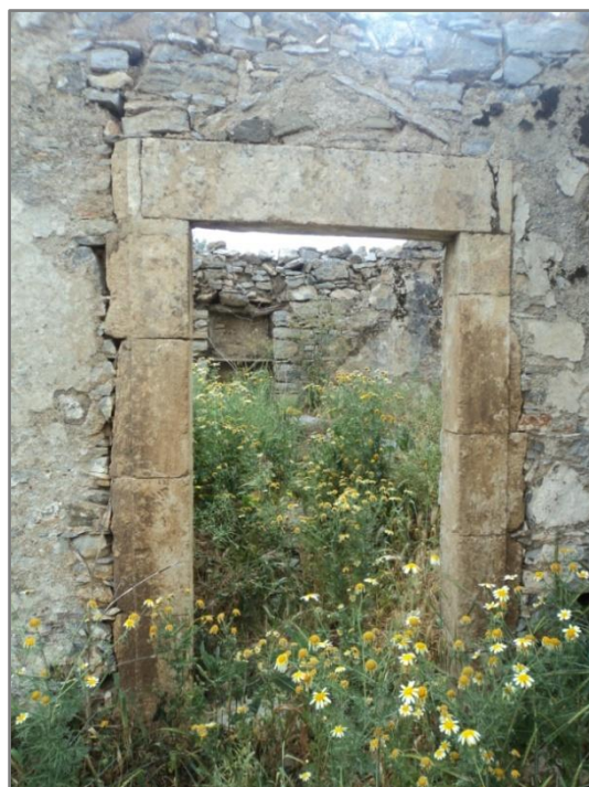
Εικ. 3.11. Εξωτερική διαμόρφωση ανοίγματος πόρτας με τριγωνικό ανακουφιστικό σχηματισμό στο ανώφλι.
