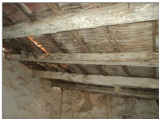
Εικ. 4.27. Φυσικά δομικά υλικά κατασκευής στέγης.
