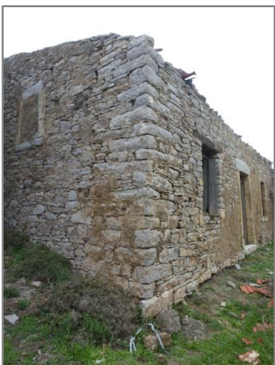
Εικ. 5. Γωνία εξωτερικής τοιχοποιίας.
