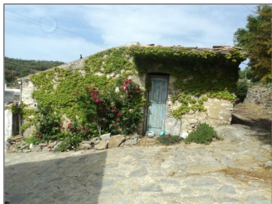
Εικ. 4.33. Αναρριχητικά φυτά στην πρόσοψη κτίσματος.
