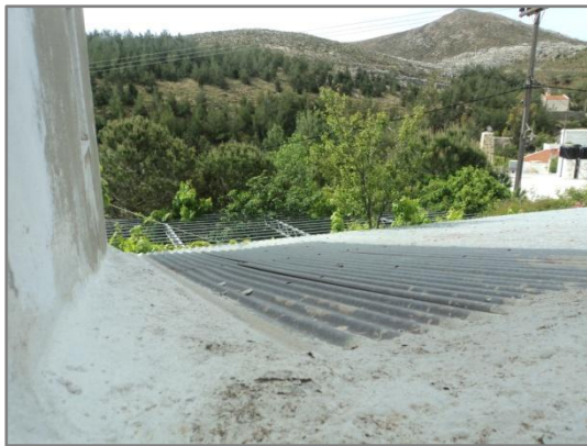
Εικ. 5.37. Επικλινή στέγη από σύγχρονα δομικά υλικά.
