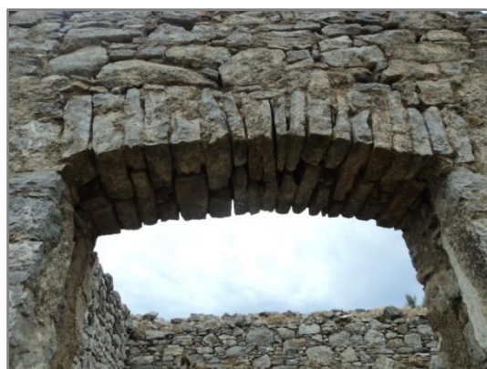
Εικ. 3.13. Ανώφλι εξωτερικής αψιδωτής πόρτας.
