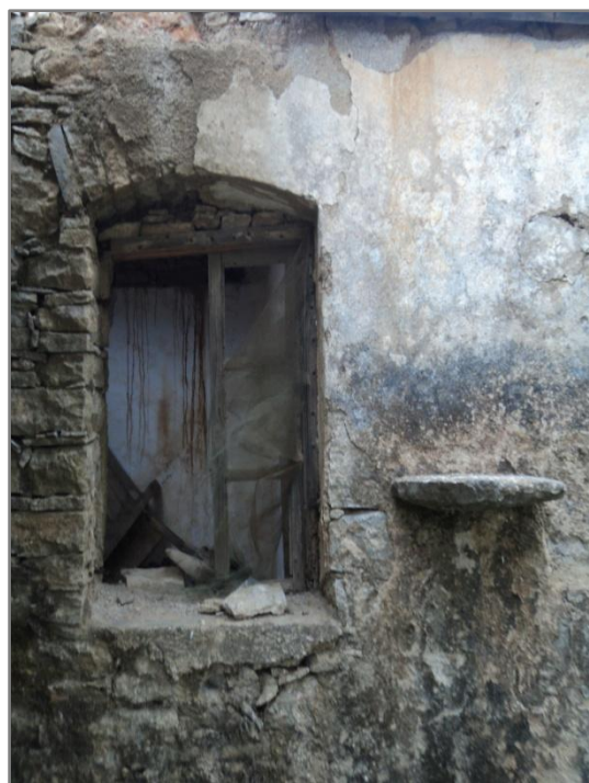
Εικ. 3.25. Παράθυρο με χαμηλό τοξωτό ανώφλι και βασιλικόπλακα (προεξέχουσα της τοιχοποιίας σχιστόπλακα).
