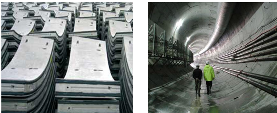
Εικόνα 5.2: Προκατασκευασμένα τμήματα από οπλισμένο σκυρόδεμα και κατασκευή τελικής επένδυσης.
