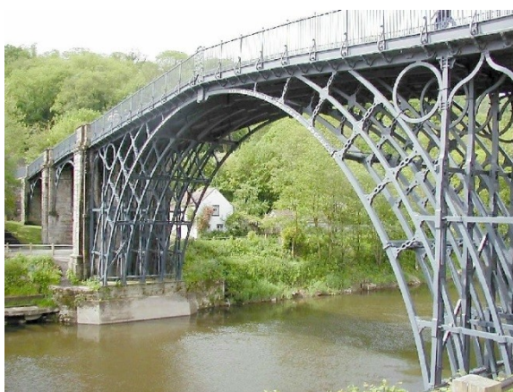
Η γέφυρα του Coalbrookdale Thomas F. Pritchard.
