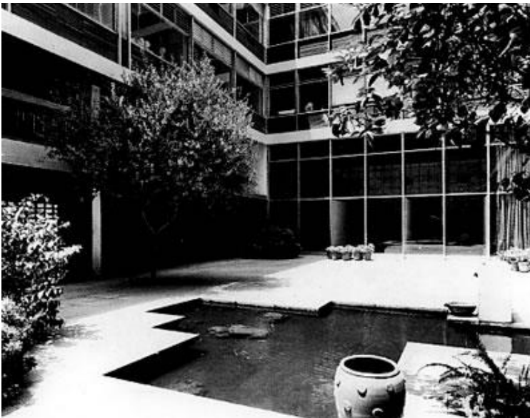
[Το κτίριο του Γραφείου Δοξιάδη αποτελεί μια από τις πρώτες και αυθεντικότερες εκφράσεις του μπρουταλιστικού κώδικα του Le Corbusier στην Ελλάδα. Χωροθετημένο στην πλαγιά του λόφου του Λυκαβηττού, το μεγάλο αυτό αρχιτεκτόνημα 'κτίζει το τοπίο', υποβαθμίζοντας το φυσικό κάλλος και την ιστορική του σημασία.]
