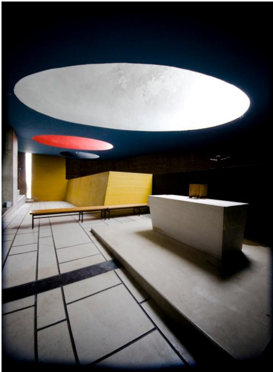
Εικ 3.28 Τα παρεκκλήσια φωτίζονται με "κανόνια" φωτός με κλίση που δεν επιτρέπει την θέαση του ουρανού[ http://openbuildings.com/ ]
