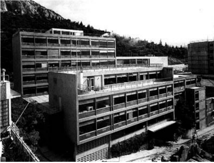
Εικ 4.17 [Κτίριο Γραφείου Δοξιάδη Στρατιωτικού Συνδέσμου 24, Λυκαβηττός, Αθήνα, 1955-1961 Αρχιτέκτονες Κωνσταντίνος Δοξιάδης (1913-1975) Τίτος Κουραβέλος (1921- ) Αρθούρος Σκέπερς (1912-2000)]
