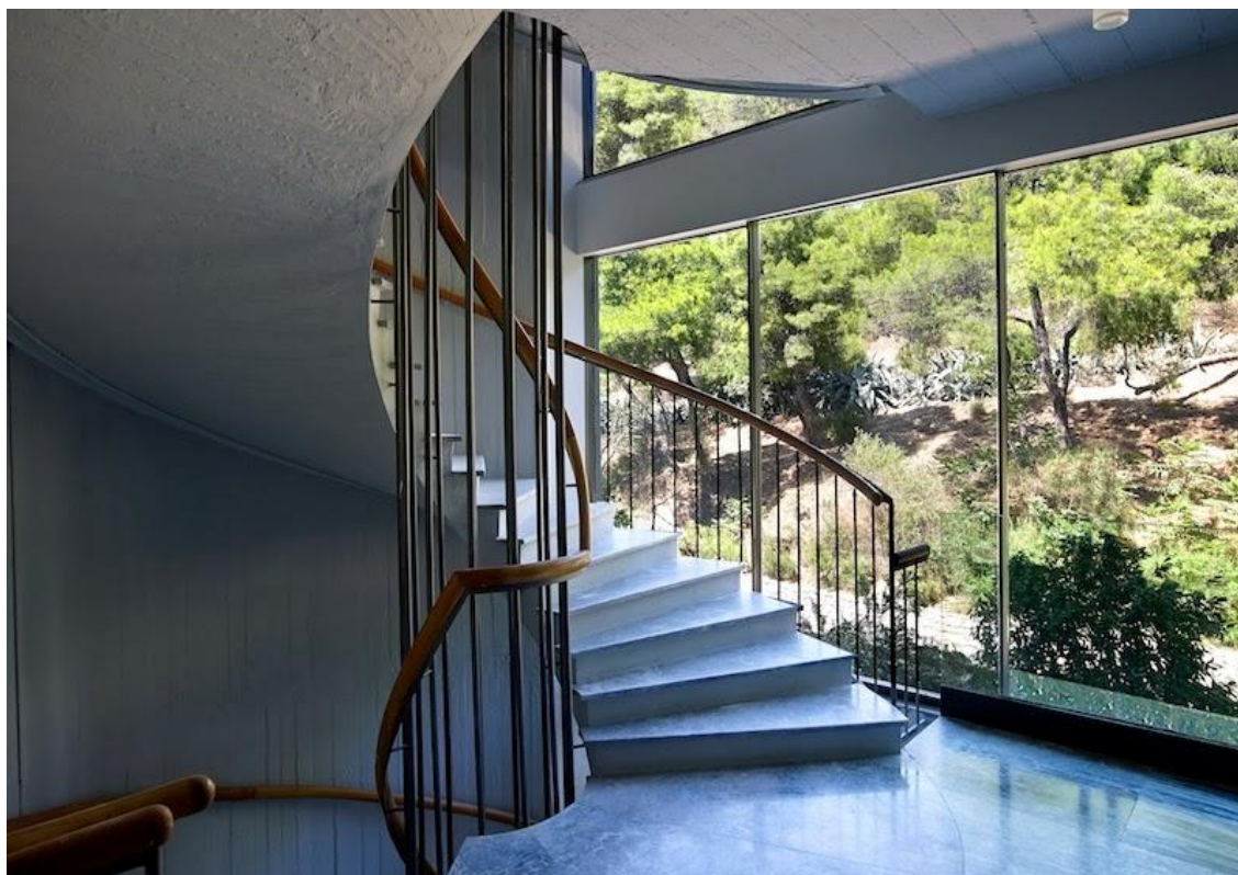
Εικ 4.16 Άποψη του διατηρητέου κλιμακοστασίου του κτηρίου[ http://www.greekarchitects.gr/ ]
