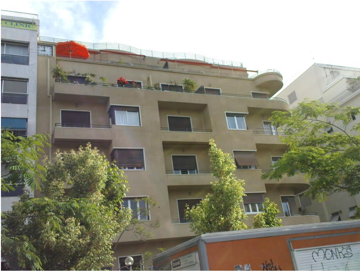
Εικ. 4.6 Πολυκατοικία του μεσοπολέμου σχεδιασμένη από τον αρχιτέκτονα Νικολαΐδη. Πλήρης ανακαίνιση και αντικατάσταση των στοιχείων της όψης. Εικονογραφική τεκμηρίωση και επίλυση ενός ενδιαφέροντος κατασκευαστικού προβλήματος δεδομένου ότι τα στοιχεία πλήρωσης της όψης έφεραν οπλισμό που είχε υποστεί διάβρωση αφήνοντας ένα κενό 5χιλ. μεταξύ της πλήρωσης και του χωρίς σημαντικές ρωγμές αρτιφισιέλ σε όλη την επιφάνεια της όψης [http://www.skyscrapercity.com/]
