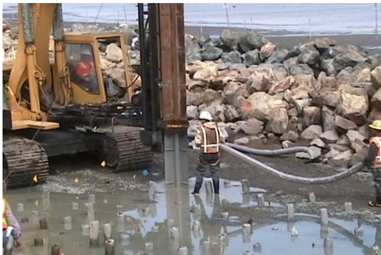
Εικόνα 4-3 Εγκατάσταση στραγγιστηρίων EQ-drains στη γέφυρα του κόλπου (NILEX Corporation, 2004)
