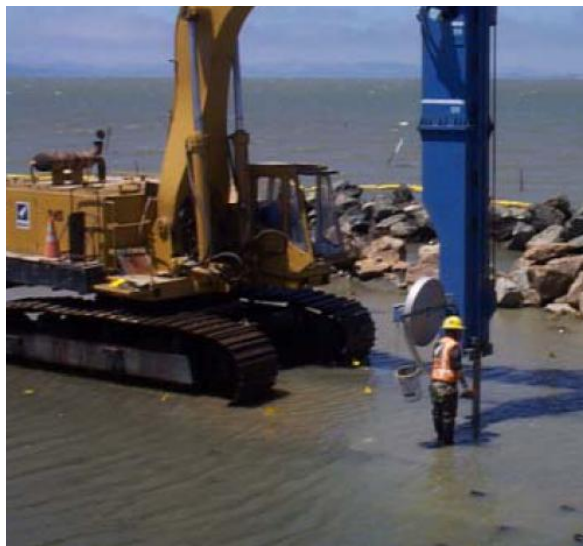
Εικόνα 4-2 Εγκατάσταση στραγγιστηρίων με διαμήκη πυρήνα στη γέφυρα του κόλπου (NILEX Corporation, 2004)
