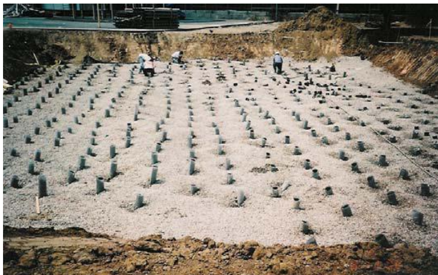
Εικόνα 4-5 Περικομμένα στραγγιστήρια σε ομοιόμορφο ύψος στη Βιβλιοθήκη του Δημοτικού Σχολείου στο Barnard (Rollins et al., 2004)
