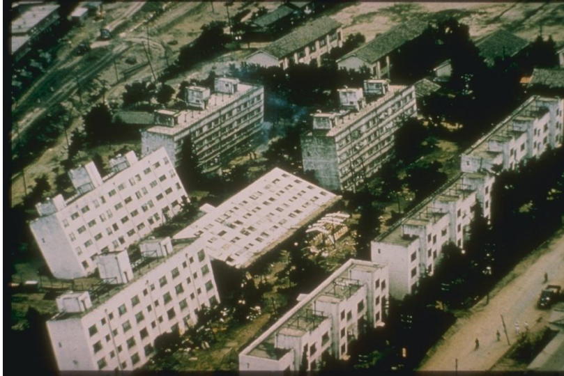
Εικόνα 2-3 Ανατροπή κτιρίων μετά το σεισμό στη Niigata το 1964
