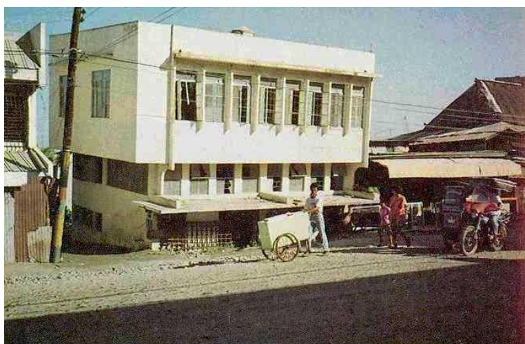
Εικόνα 2-2 Καθίζηση της υπερκείμενης κατασκευής στην Dagupan στις Φιλιππίνες το 1990
