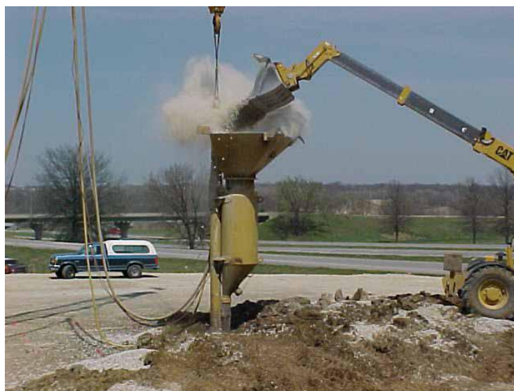
Σχήμα 3-5 Κατασκευή χαλικοπασσάλου στο I-35/Hwy 5 στο West Des Moines, Iowa (Pitt et al., 2003)
