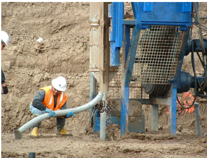
Εικόνα 4-1 Τοποθέτηση του στραγγιστηρίου στο στέλεχος (NILEX Corporation, 2004)
