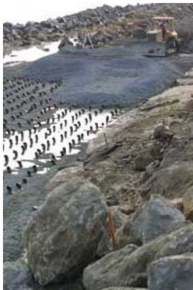
Εικόνα 4-4 Τοποθέτηση στρώματος από χάλικες (NILEX Corporation, 2004)
