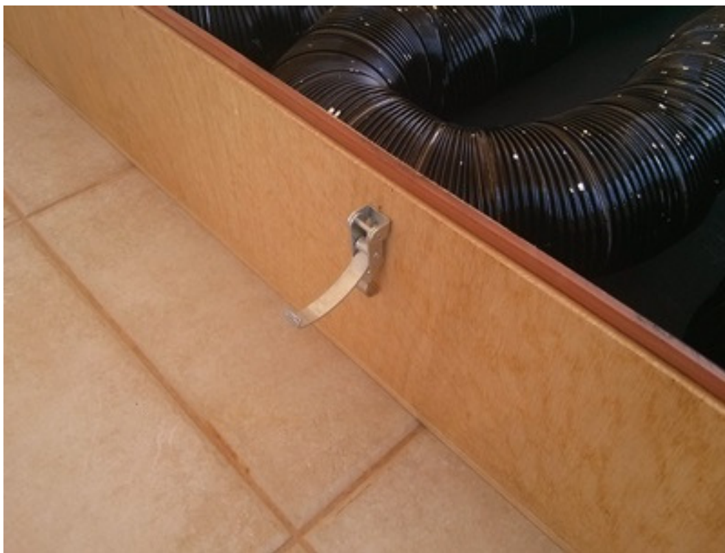
Εικόνα 2 : Εφαρμογή ελαστικού EPDM και άγκιστρον συγκράτησης
