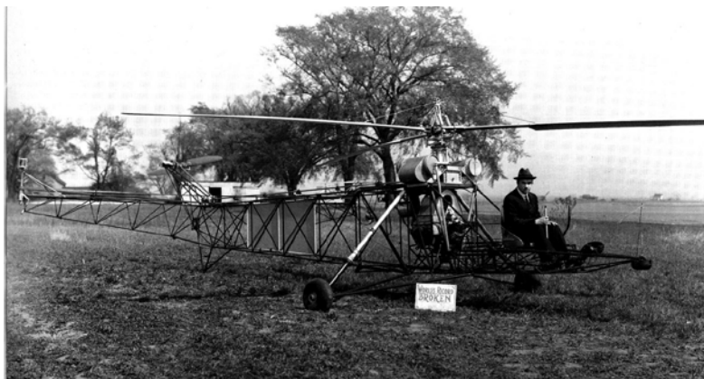
Εικόνα 1.10: Η βιομηχανία των ελικοπτέρων άρχισε το 1939 στις ΗΠΑ με το Sikorsky VS-300 που ήταν το πρώτο ελικόπτερο.
