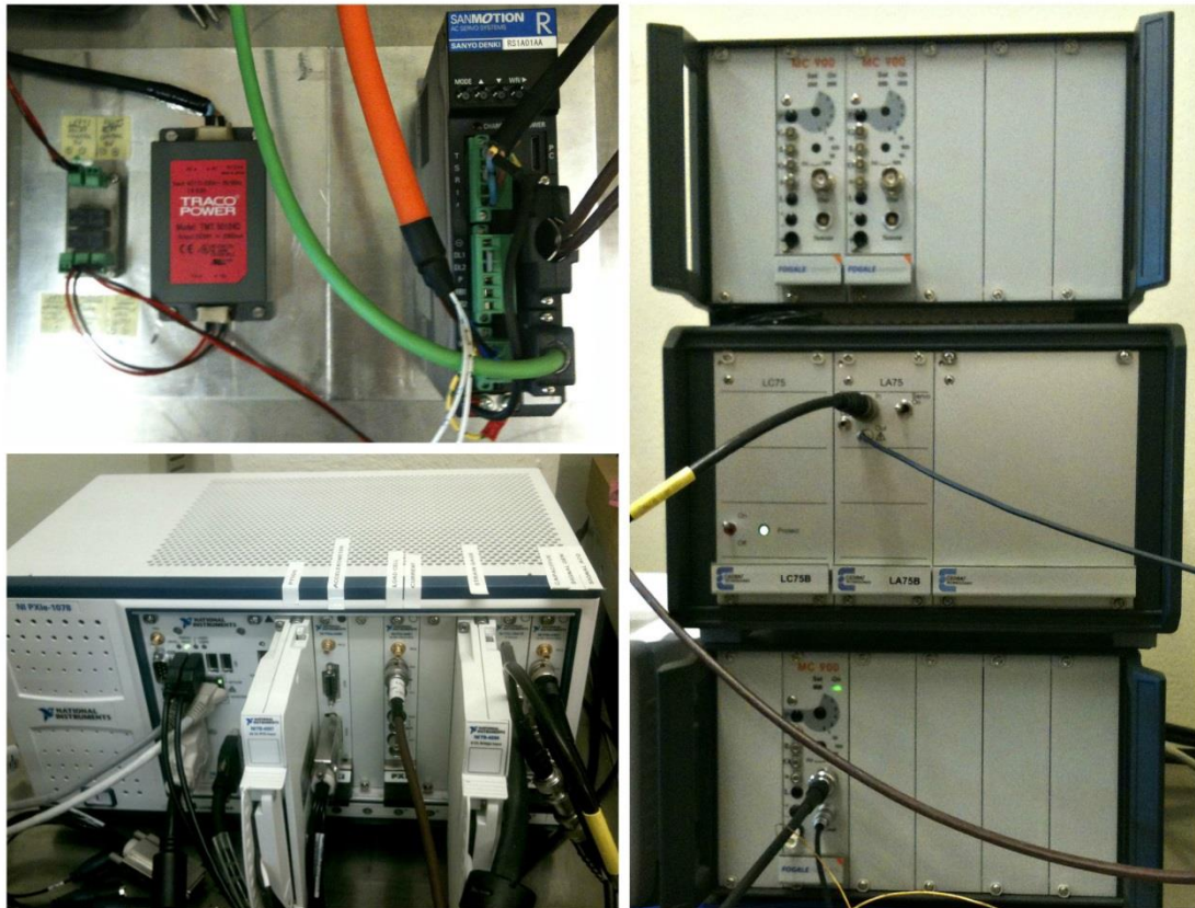
Σχήμα 2. 2: Περιφερειακές συσκευές- National Instruments PXI chassis και modules (κάτω-αριστερά), ενισχυτής σερβοκινητήρα και τροφοδοσία του μηχανικού φρένου (πάνω-αριστερά) και γραμμικοί ενισχυτές για διέγερση του πιεζοηλεκτρικού στοιχείου και μετρήσεις του capacitive sensor(right)
