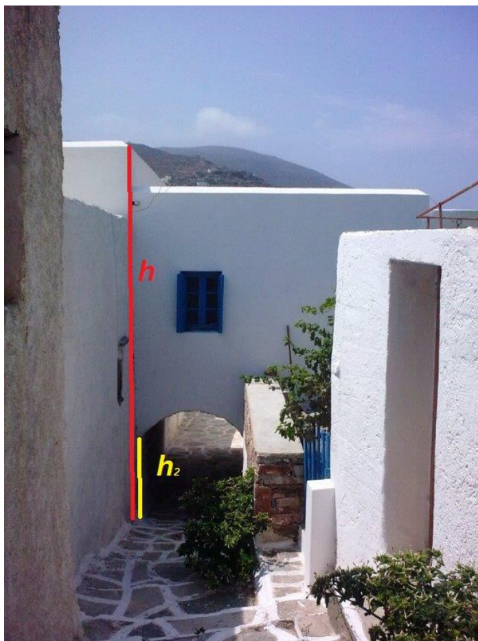
Εικόνα 37 Τα μετρημένα ύψη κτιρίου που θα πρέπει να αναγράφονται στο συμβόλαιο και στο Τοπογραφικό Διάγραμμα
