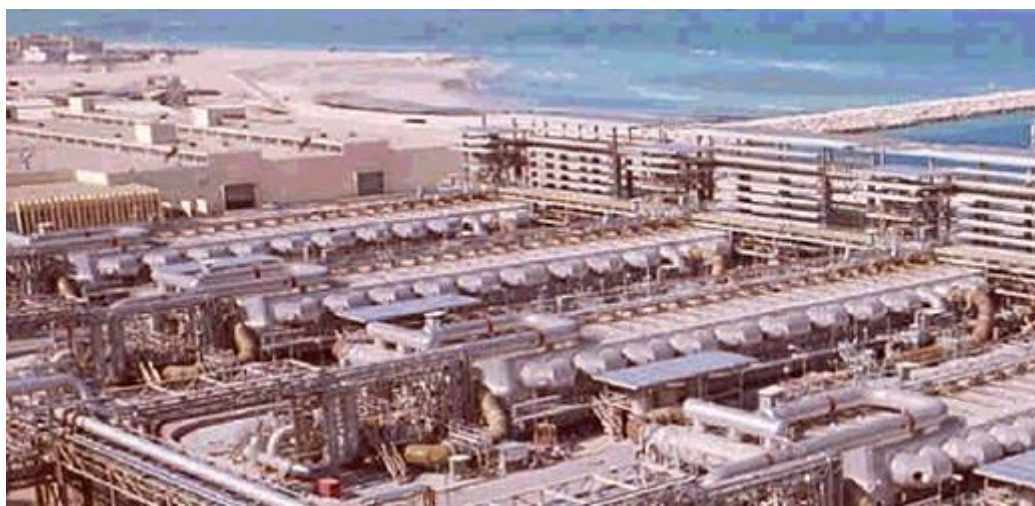
Φωτογραφία 2.1: Εγκατάσταση με πολυβάθμια εκτόνωση στη Σαουδική Αραβία δυναμικότητας 138.000 κ.μ την ημέρα. [14]
