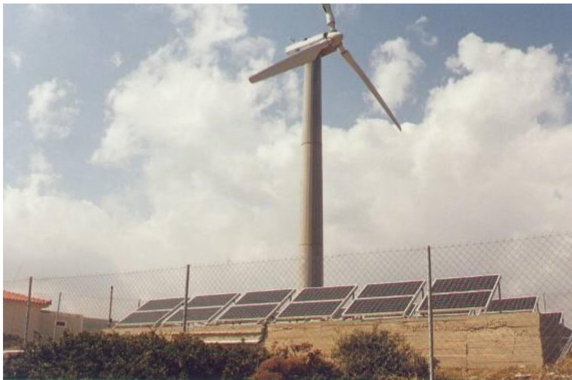
Φωτογραφία 2.7: Υβριδικό σύστημα με Α/Γ και φωτοβολταϊκά στο πάρκο του ΚΑΠΕ στο Λαύριο [40]
