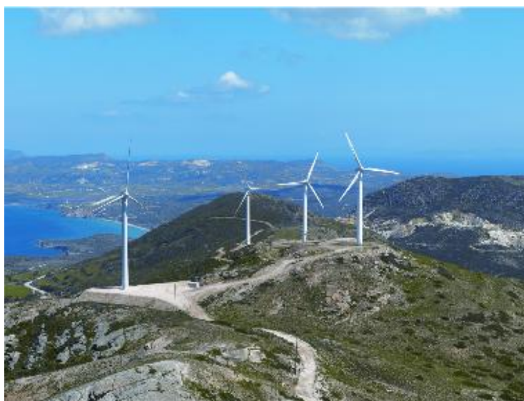
Φωτογραφία 2.5: Αιολικό πάρκο στη θέση Κουτσουνοράχη στη Μήλο [7]
