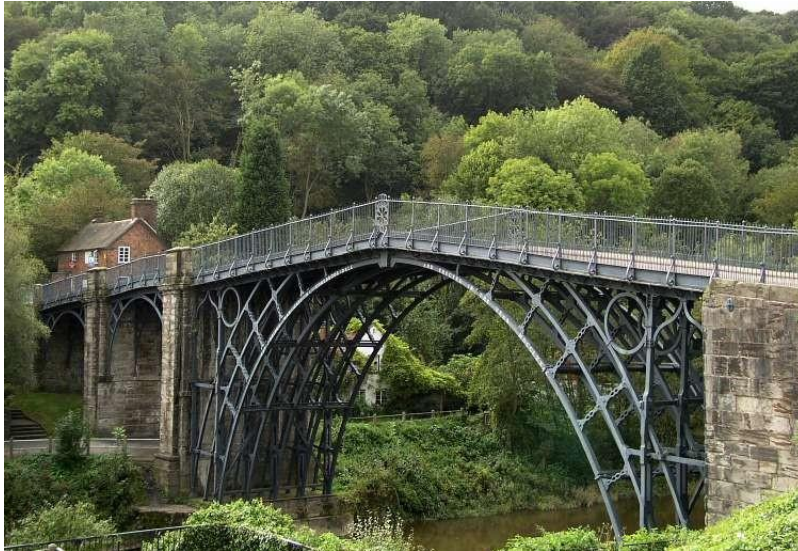
Εικόνα 1.1. Η πρώτη γέφυρα από χυτοσίδηρο Coalbrookdale, Αγγλία 1777
