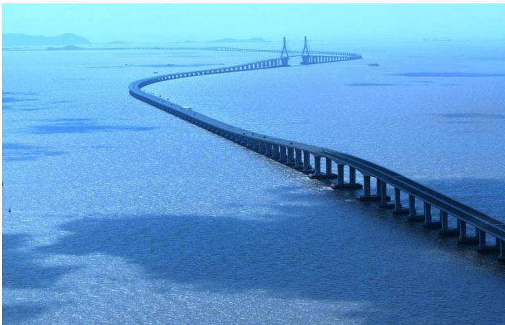
Εικόνα 1.8. Hangzhou Bay Bridge, η μακρύτερη γέφυρα στον κόσμο
