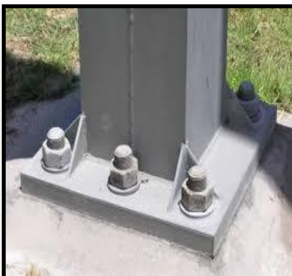
Εικόνα 9.9. Απεικόνιση μεταλλικού υποστρώματος στην έδραση
