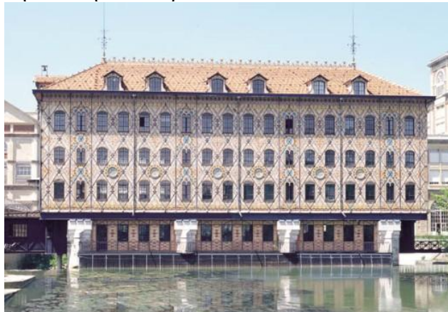
Εικόνα 1.4. Το πρώτο κτίριο με μεταλλικό σκελετό της Γαλλίας, στο Noisiel Sur Marne, Γαλλία, 1872
