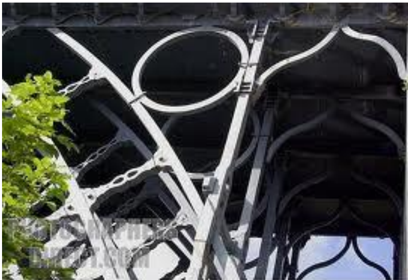
Εικόνα 1.2. Λεπτομέρεια αψιδωτού σκελετού της γέφυρας του Coalbrookdale, Αγγλία 1777
