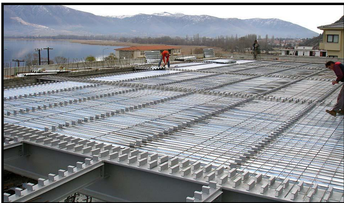
Εικόνα 9.7. Σύμμικτη πλάκα με διατμητικούς ήλους
