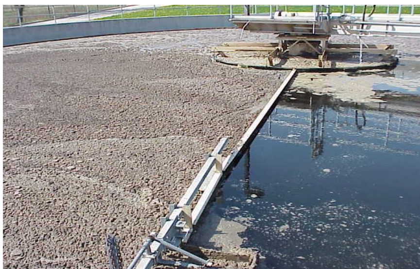
Εικόνα 2.2: Αφρισμός σε δεξαμενή τελικής καθίζησης
