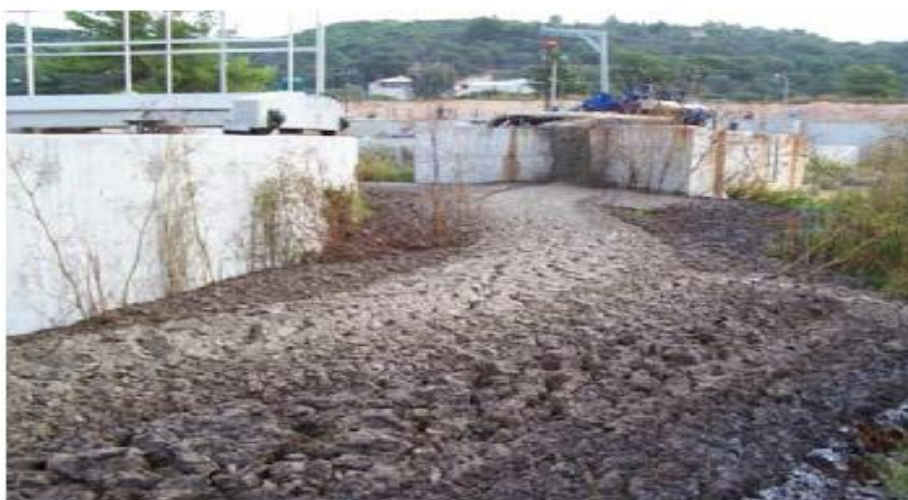
Εικόνα 2.5: Αφρός που έχει υπερχειλίσει και έχει διαφύγει των μονάδων
