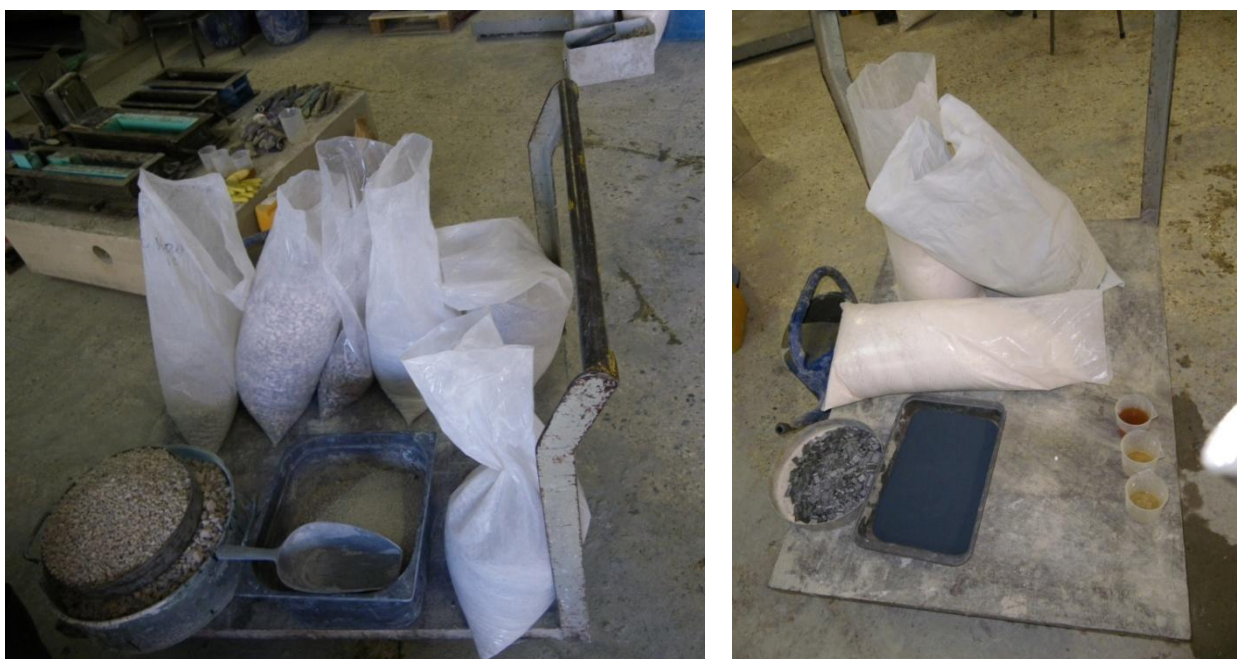
Εικόνα 5-4: Συγκέντρωση απαραίτητων υλικών προς σκυροδέτηση
