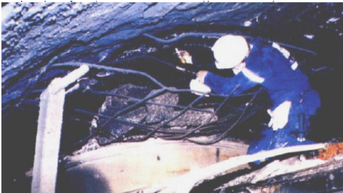
Εικόνα 4-1: Τυπικές περιπτώσεις βλαβών ύστερα από εκδήλωση πυρκαγιάς
