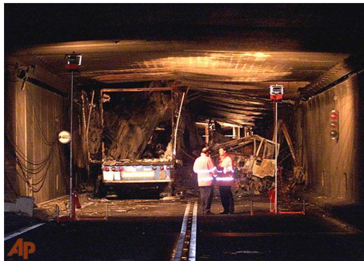
Εικόνα 4-2: Επιπτώσεις πυρκαγιάς σε σήραγγα
