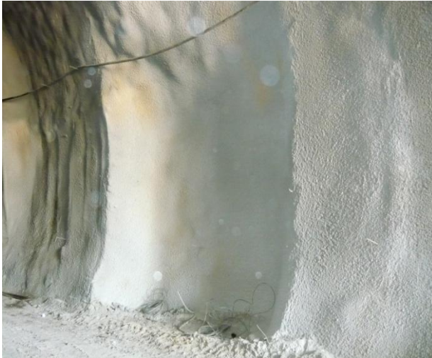
Εικόνα 2-1: Εκτοξευόμενο σκυρόδεμα σε τοιχώματα σήραγγας
