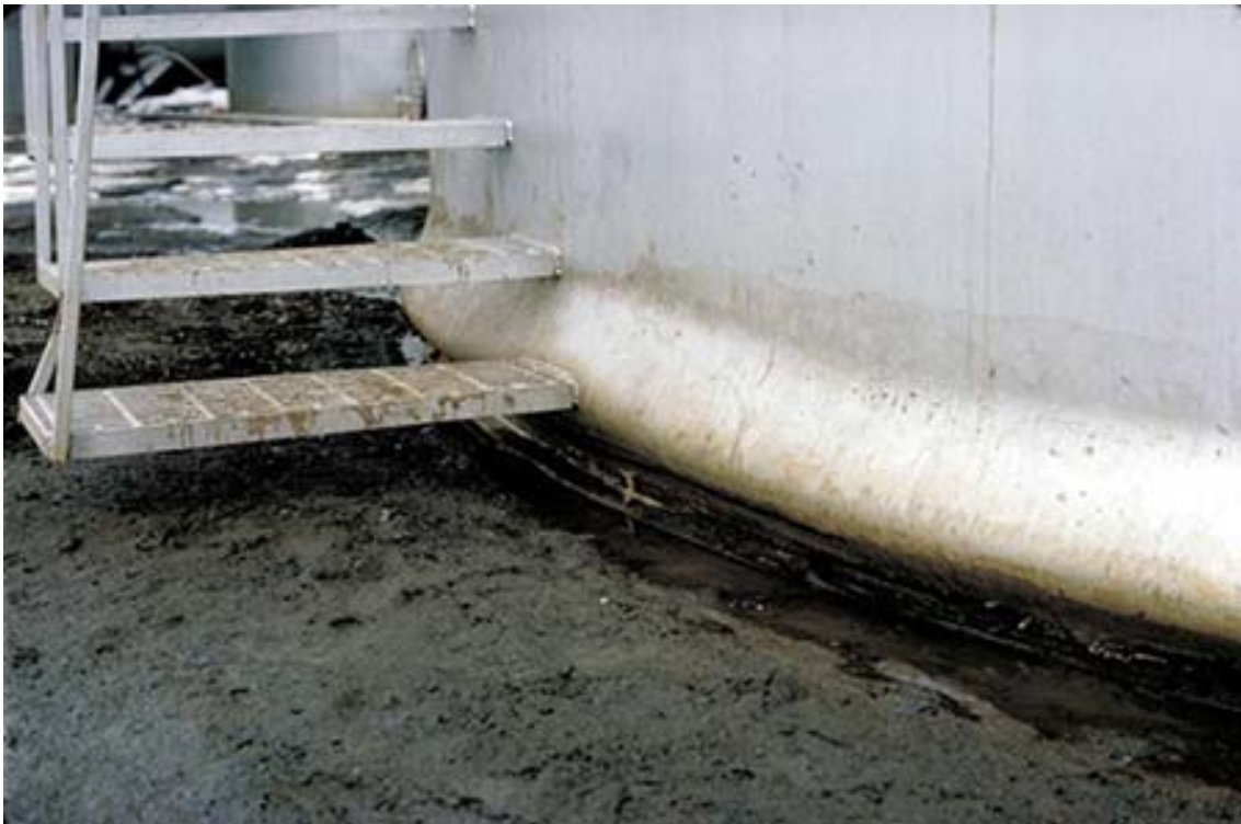
Εικόνα 1.1 Λυγισμός του κελύφους στη βάση της δεξαμενής τύπου “elephant-foot” (1964 magnitude-9.2 Anchorage, Alaska earthquake)
