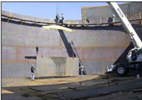
Εικόνα 1.6 Κατασκευή συγκολλητής μεταλλικής δεξαμενής
