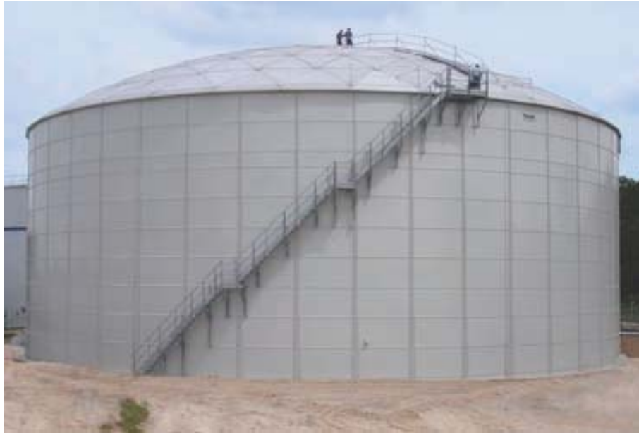
Εικόνα 1.7 Μεταλλική δεξαμενή με κοχλιωτές συνδέσεις
