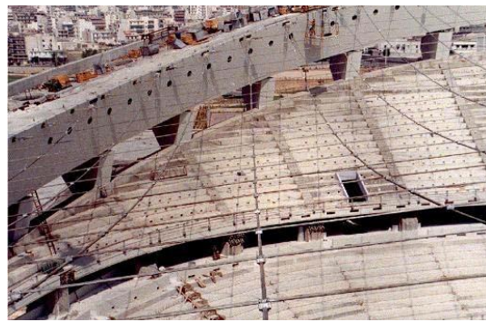
Εικόνα 1.2.2 Σύνδεση και αγκύρωση καλωδίων
