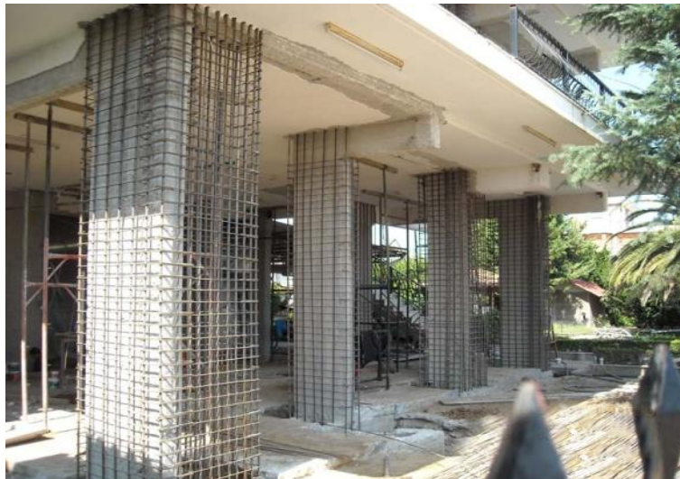
Σχ.7.2. Εφαρμογή μανδύων οπλισμένου σκυροδέματος
