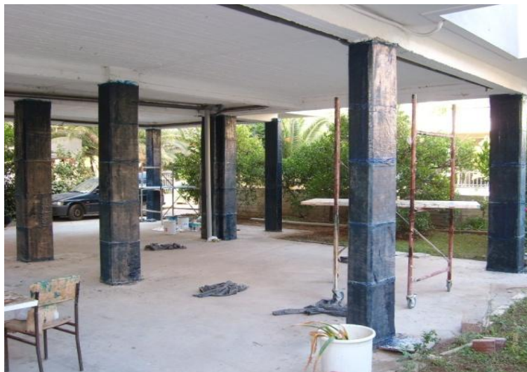
Σχ.7.4. Εφαρμογή υφασμάτων ινοπλισμένων πολυμερών άνθρακα.
