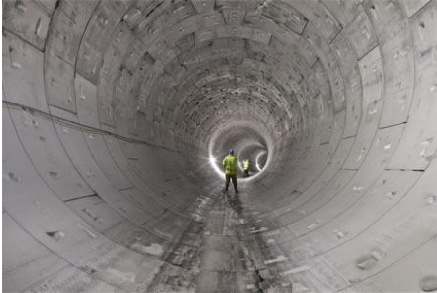
Εικόνα 6: Σήραγγα επενδεδυμένη με ινοπλισμένα προκατασκευασμένα στοιχεία
