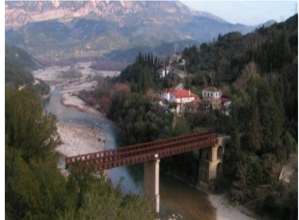
Φωτογραφία 5: Η γεφυρα μετά την τοποθέτηση μεσοβάθρου
