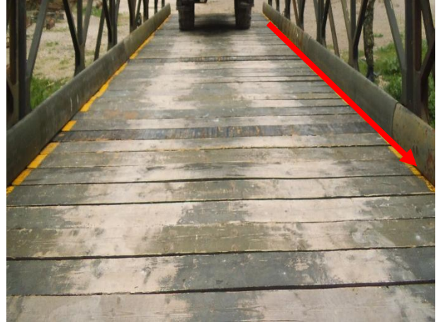
Φωτογραφία 8: Κατάστρωμα με επιζυγίδες της συλλογής γέφυρας Bailey
