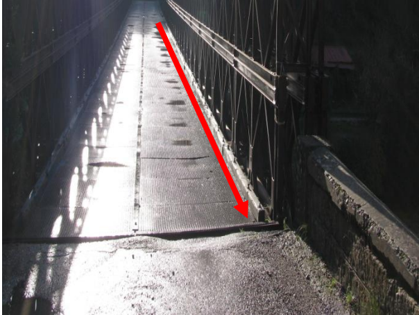
Φωτογραφία 7: Αυτοσχέδιες Επιζυγίδες σε Τριπλό-Διπλό Φορέα στο Θέρμο Αιτωλοακαρνανίας
