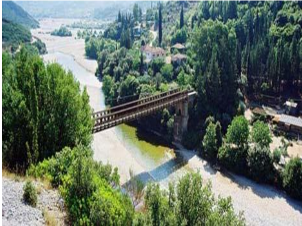
Φωτογραφία 4: Η γέφυρα του Θέρμου πρίν την τοποθέτηση του μεσοβάθρου
