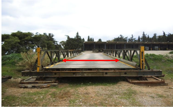
Φωτογραφία 11:Ωφέλιμο πλάτος γέφυρας 3,81 m
