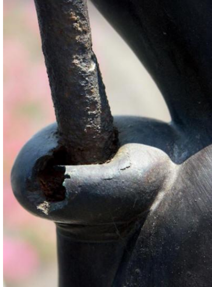
Σχήμα 1.5 : Διάβρωση με μηχανική καταπόνηση μπρούτζινης κατασκευής
