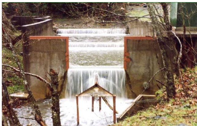
Εικόνα 9: Υδρομετρικός σταθμός ορθογωνικής διατομής στην έξοδο της πειραματικής λεκάνης (Μπουρλέτσικας,2004).
