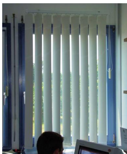
Εικόνα 4.2.1.7.1: Κατακόρυφες γρίλιες με ένυδρο άλας (αριστερά) και οριζόντιες γρίλιες με PCM (δεξιά)
