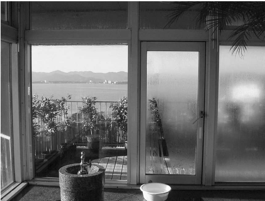
Εικόνα 68 Το γυαλί που εμφανίζεται στην αριστερή πλευρά εμποδίζεται από το να θολώσει ακόμη σε ένα κορεσμένο σε υδρατμούς περιβάλλον,
