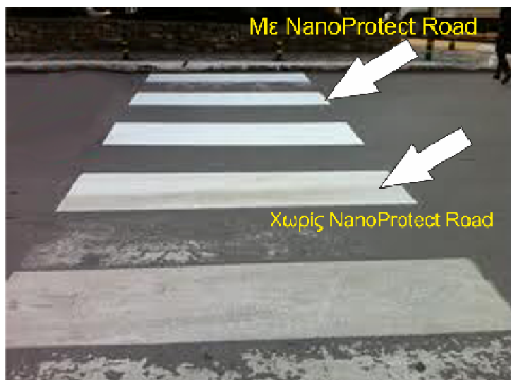
Εικόνα 67: Χρήση αυτοκαθαριζόμενου χρώματος διαγράμμισης (εμπορική ονομασία nannoprotect road)
