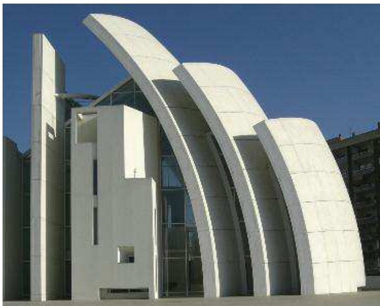
Εικόνα παραρτήματος: 8 Η εκκλησία της Misericordia στη Ρώμη. Αποτελεί το πρώτο κτίριο που κατασκευάστηκε με φωτοκαταλυτικό τσιμέντο).
