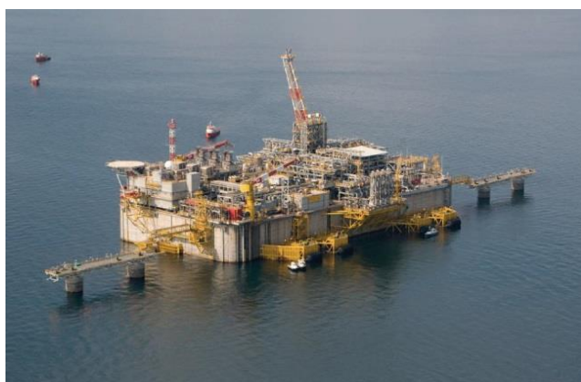
Σχήμα 3.10: Εναέρια φωτογραφία του Τερματικού σταθμού ADRIATIC (πηγή: www.worldlngnews.com )
