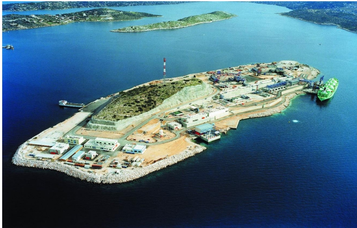
Σχήμα 2.1: Φωτογραφία Τερματικού Σταθμού ΥΦΑ νήσου Ρεβυθούσας (πηγή: www.lngworldnews.com )
