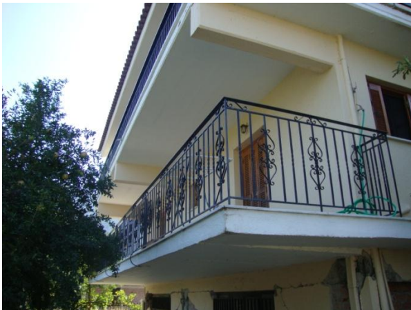
Εικόνα 4.4 Δημιουργία μαλακού ορόφου – Συγκέντρωση βλαβών στη στάθμη του ισογείου
