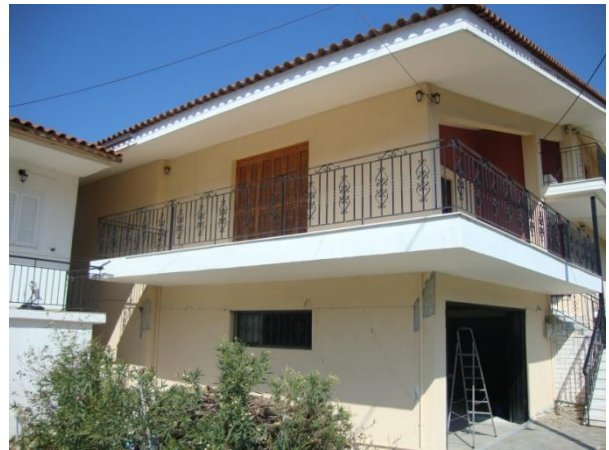
Εικόνα 4.4 Δημιουργία μαλακού ορόφου – Συγκέντρωση βλαβών στη στάθμη του ισογείου
