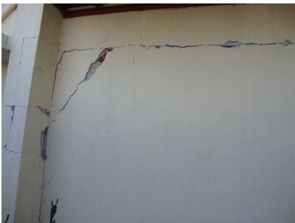
Εικόνα 4.5 α) Μη προσεγμένη κατασκευή τοιχοπληρώσεων β) Εκτός επιπέδου αστοχία τοιχοπληρώσεων
