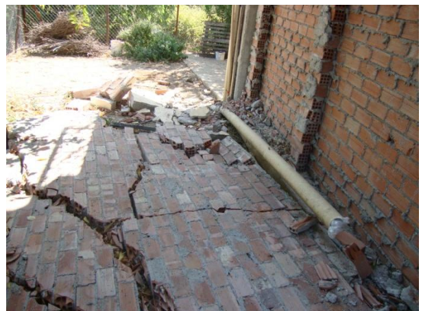
Εικόνα 4.5 α) Μη προσεγμένη κατασκευή τοιχοπληρώσεων β) Εκτός επιπέδου αστοχία τοιχοπληρώσεων
