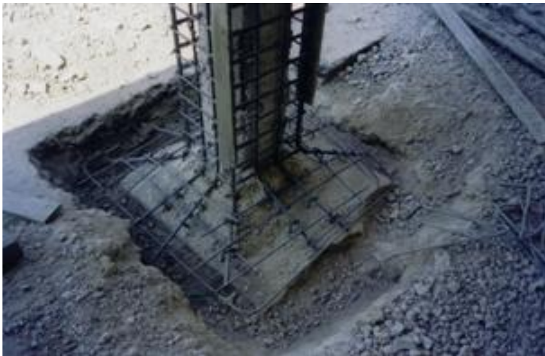
Σχήμα. 2.3 Ενίσχυση υποστυλώματος - θεμελίου με μανδύα οπλισμένου σκυροδέματος
