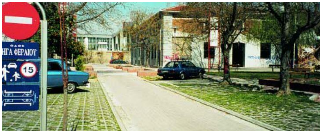
Εικόνα 53: Οδός Ρήγα Φεραίου. Διακοπή διαμπερότητας με παρεμβολή πλήρως πεζοδρομημένου τμήματος με καθιστικά. Ο διάδρομος κίνησης εξυπηρετεί την πρόσβαση στις θέσεις στάθμευσης. Ενδιαφέρον παρουσιάζει η πληροφοριακή σήμανση ως προς τη στάθμευση. (Πηγή: Υπουργείο Περιβάλλοντος Ενέργειας και Κλιματικής Αλλαγής - http://www.minenv.gr/5/53/bikes/kef4.pdf )
