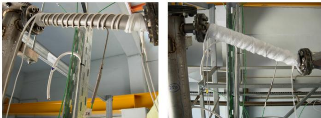
Εικόνα 2.38. Τοποθέτηση αντιστάσεων στον σωλήνα ένωσης με τον κυκλώνα
