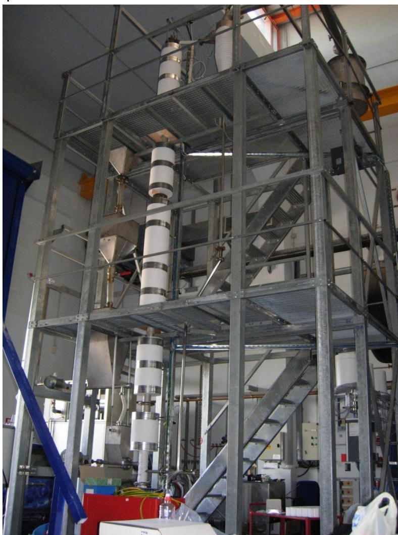
Εικόνα 2.34. Ηλεκτρικές αντιστάσεις Kanthal κατά μήκος του αντιδραστήρα.
