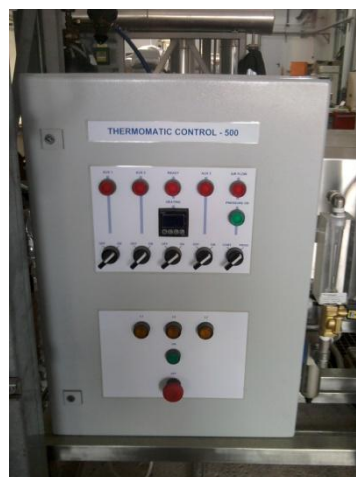
Εικόνα 2.25 . Πίνακας ελέγχου προθερμαντήρα
