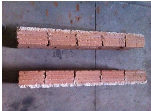
Εικόνα 1.20: Τομή εξωτερικής τοιχοποιίας Κτιρίου 'Ο'
