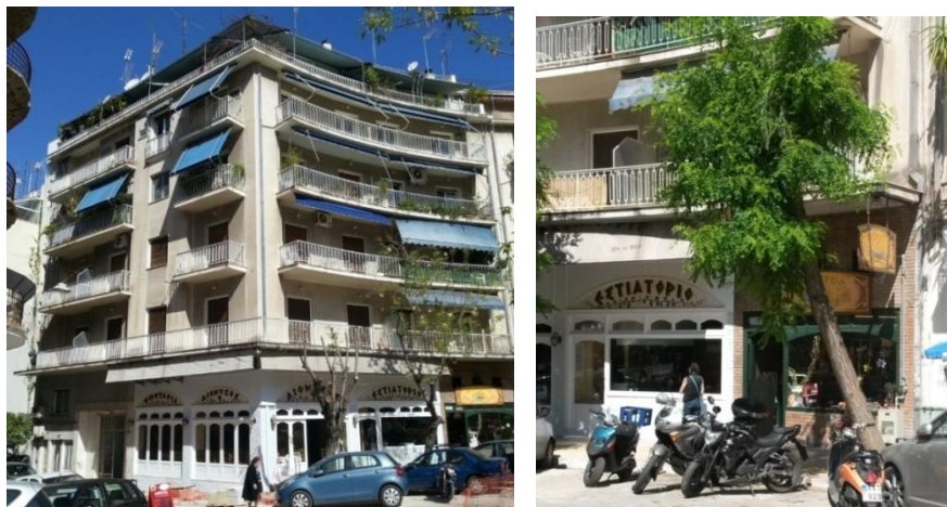
Εικόνα 5-40: Πρόσωση πολυκατοικίας επί της πλατείας Αγ. Γεωργίου Εικόνες 5-41: Αρτοποιείο επί της πλατείας Αγ. Γεωργίου
