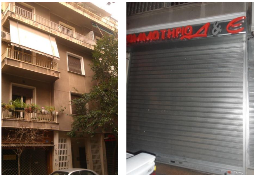
Εικόνες 5-16, 5-17: Πρόσοψη πολυκατοικίας και: Κατάστημα
