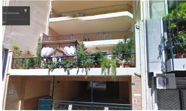
Εικόνα 5-49: Πρόσψη διαμερίσματος Πηγή: Google maps
