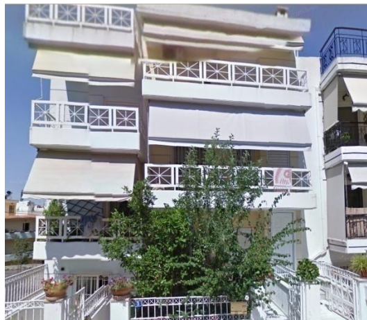
Εικόνα 5-47: Ανατολική όψη διαμερίσματος στην οδό Ο. Κωνσταντινίδου Πηγή: Google maps
