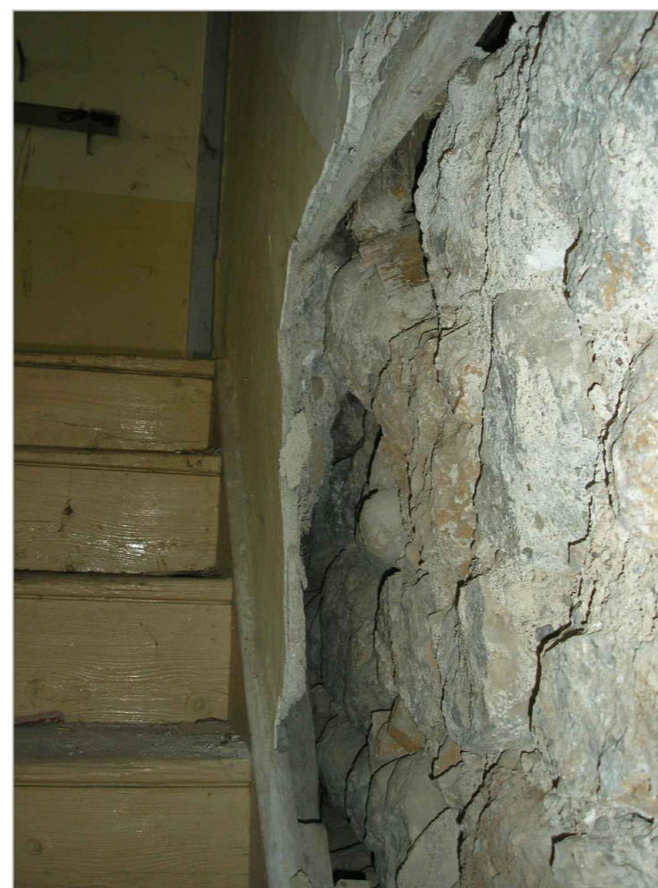
10 ΣΚΑΛΑ- ΑΠΟΨΗ ΤΗΣ ΛΙΘΟΔΟΜΗΣ
