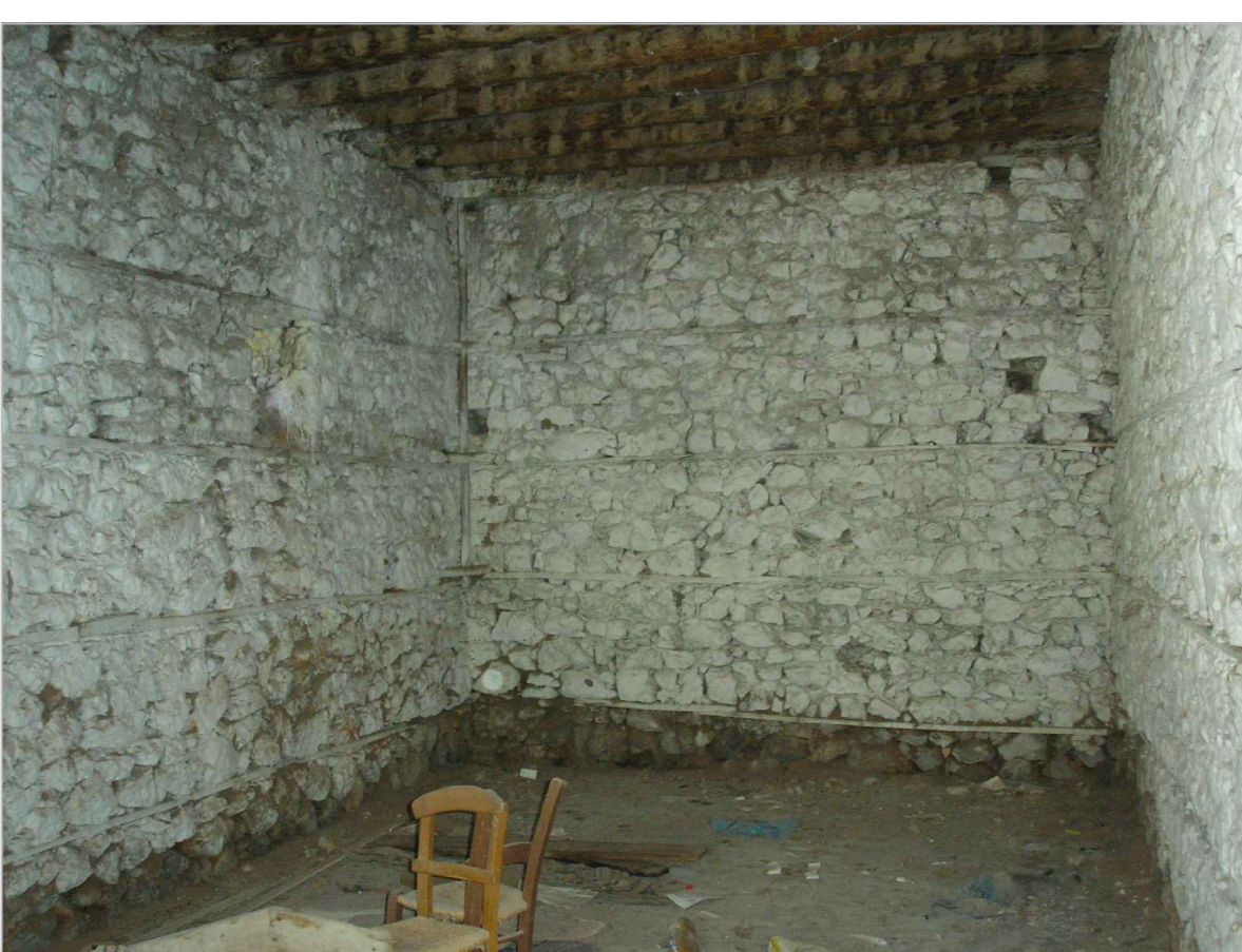
9 ΚΑΤΩ- ΔΙΑΚΡΙΝΟΝΤΑΙ ΤΑ ΞΥΛΙΝΑ ΔΟΚΑΡΙΑ ΤΟΥ ΠΑΤΩΜΑΤΟΣ
