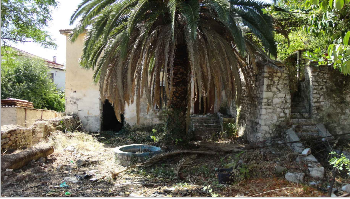
3 ΥΠΑΡΧΟΥΣΑ ΚΑΤΑΣΤΑΣΗ ΤΗΣ ΑΥΛΗΣ
