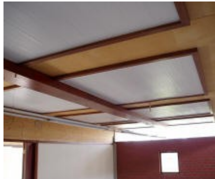
ΕΙΚΟΝΑ 4.9.4.1: ΚΛΙΜΑΤΙΣΜΟΣ ΜΕ PCM
