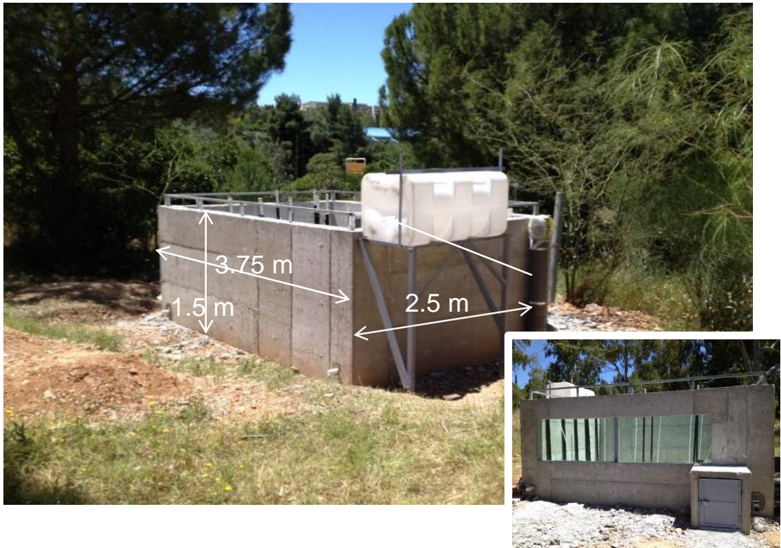
Εικόνα 9.2. Όψεις της δεξαμενής πριν την πλήρωση
