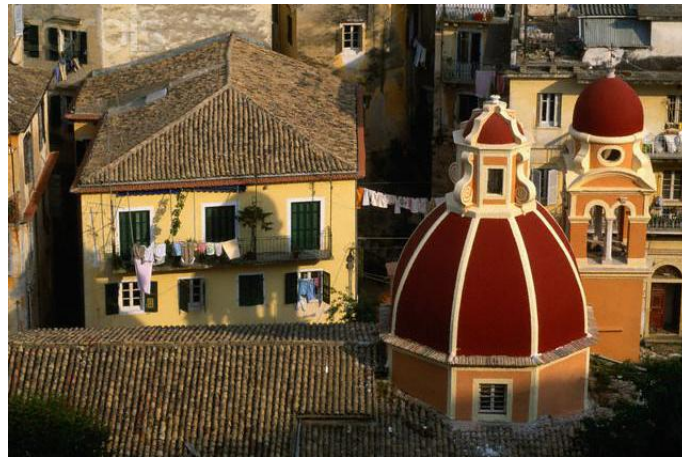
Εικόνα 72 : Παράδειγμα σκεπής σε κτίριο της Παλιάς Πόλης της Κέρκυρας (πηγή : Google, 2014)
