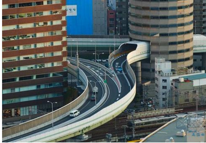
Εικόνα 38 : Αυτοκινητόδρομος υπερκείμενος ιδιωτικού γεωτεμαχίου και διερχόμενος διαμέσου του κτιρίου ανωδομής (πηγή : Google, 2014)
