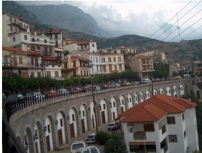
Εικόνα 35 : Ιδιόκτητοι χώροι αυτοτελούς λειτουργίας υποκείμενοι γέφυρας οδικού άξονα (πηγή: Google, 2014)
