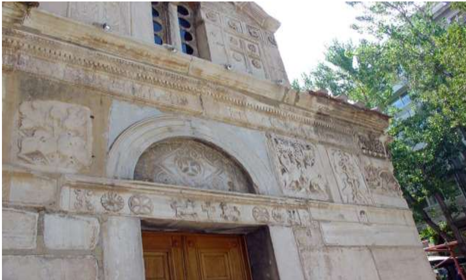
Εικ. 64 Πρόσοψη του ναού του Αγίου Ελευθερίου που βλέπει προς το Μοναστηράκι, στο τέλος της Οδού Μητροπόλεως.
