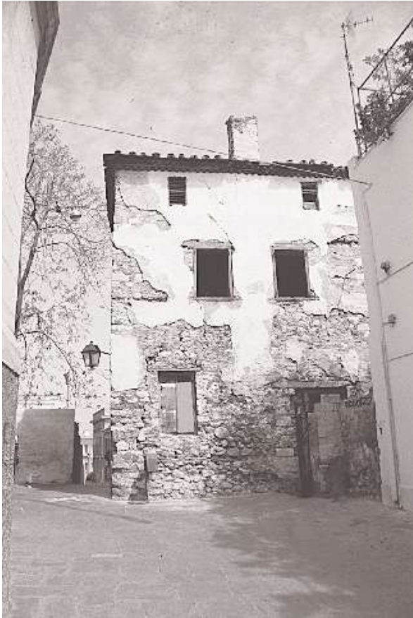
Εικ. 5 Η οικία Church. Πυργόσπιτο λαϊκού ύφους από τα παλαιότερα του είδους χωρίς διακοσμητικά στοιχεία.
