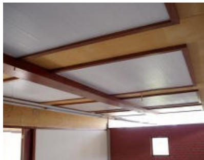
Εικόνα 5.9.4.1 : Κλιματισμός με pcm
