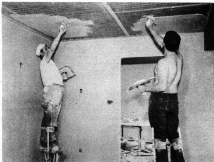
Σχ. 5.3γ. Ασβεστογυψοκονίαμα που εφαρμόζεται ως τελικό στρώμα σε οροφή.
