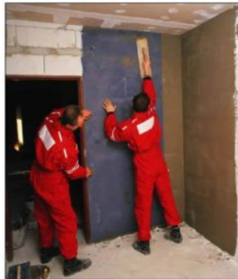
Σχ.6.5 Τοποθέτηση υαλοπλέγματος.
