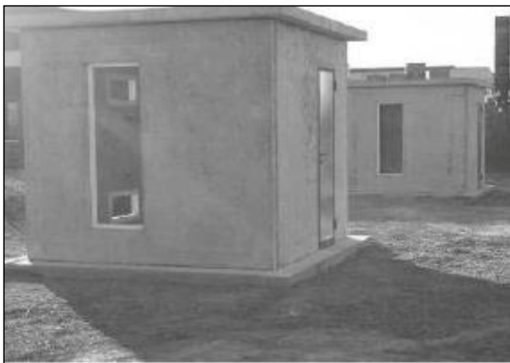
Σχήμα 3.6: Αριστερά: κτίρια δοκιμής, το ένα εκ των οποίων με τοίχους από σκυρόδεμα και το άλλο με τοίχους από σκυρόδεμα με PCM.[27]
