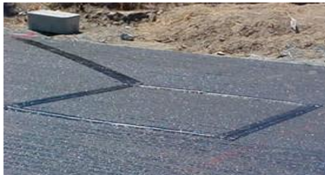
Εικόνες 4.11 και 4.12: Απλός επαγωγικός βρόχος σε σχεδιαστική απεικόνιση (αριστερά) και μετά την εγκατάσταση (δεξιά)
