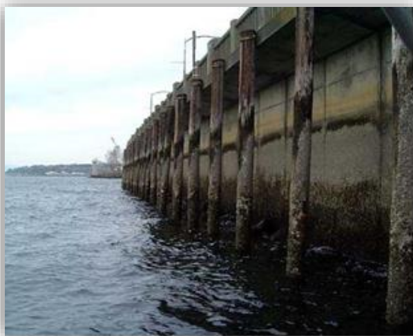
Εικόνα 2.1 Διάβρωση σε θαλάσσιο φράγμα στην Αλάσκα
