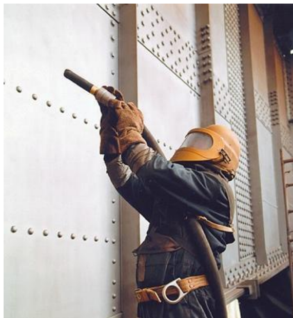
Εικόνα: Καθαρισμός με ψηγματοβολή
